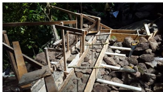
Construyendo obra toma
