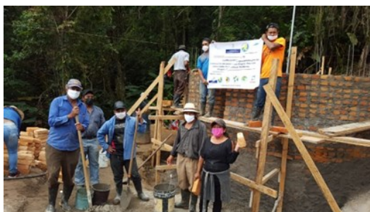
Construyendo cisterna de bombeo
