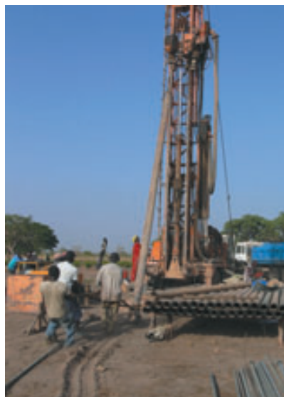
Perforación del pozo
