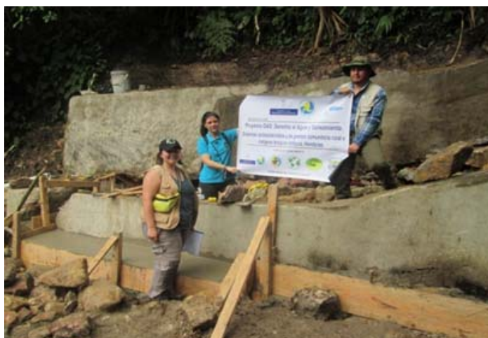
Construcción de obra toma en la comunidad de Valle de Ángeles
