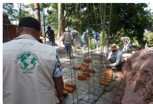
Inicio de construcción de un tanque de abastecimiento de 13.000 galones.
