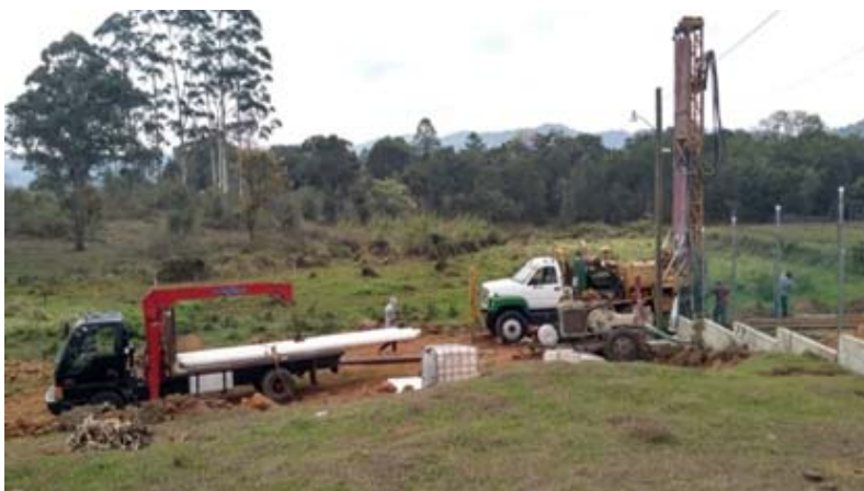
Labores de perforación del pozo de agua en el Centro Integral Misión del Amor (CIMA).
