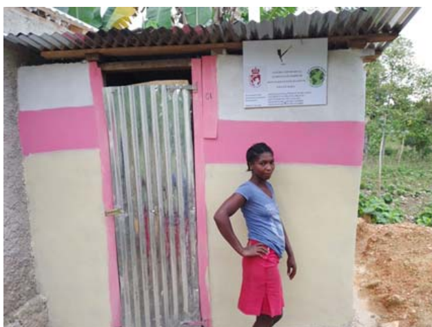
Vista frontal de una de las letrinas construidas con el cartel de agradecimiento al Ayuntamiento de Coslada
