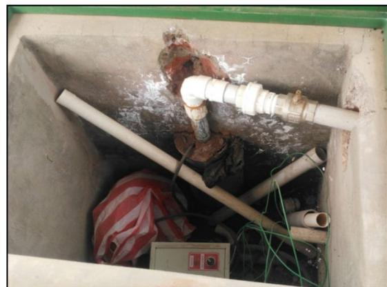
**Figura 3.7. Almacenamiento de materiales potencialmente contaminantes en el interior de las arquetas de los pozos.**
