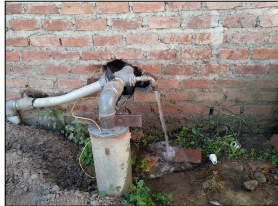
**Figura 3.5. Emboquille de pozo sin ningún tipo de protección.**
