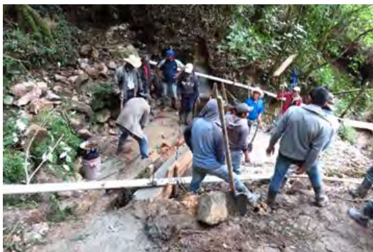
Construcción de Obra toma en la comunidad de Cedros
