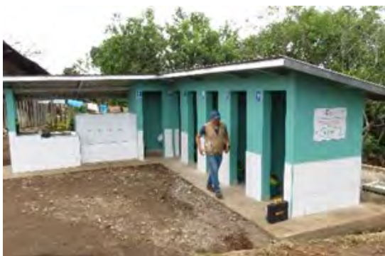
Módulos sanitarios en construcción CEB de Dulce Nombre.
