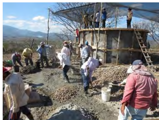
Depósito de agua en construcción para abastecer a la comunidad de La Angostura
