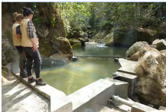
Captación finalizada para abastecer a las comunidades de El Oreganal y La Angostura.
