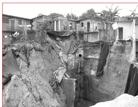
Deslizamiento de Santa Lucía
