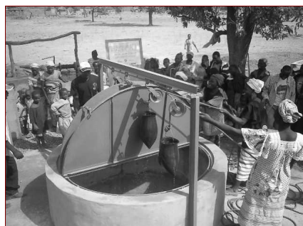
Primera extracción de agua del recién construido pozo de Beo (Malí)
