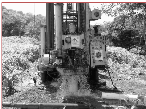
Perforación de un pozo
