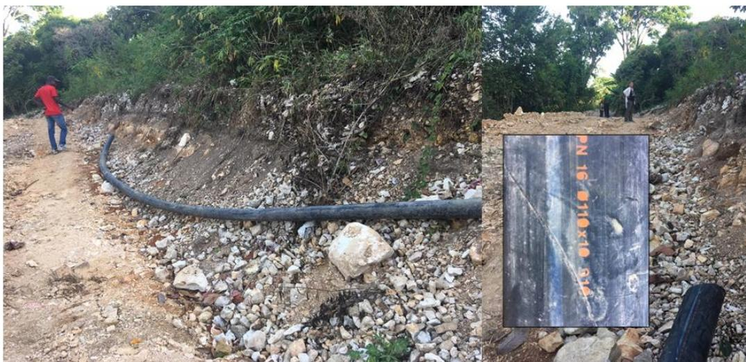
Tramo del acueducto. Para la inspección hubo que acometer excavaciones en buena parte del recorrido.
