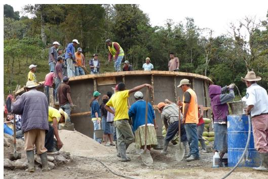
Construcción de tanque de almacenamiento de agua potable de 24.000 galones (90,850 litros).
