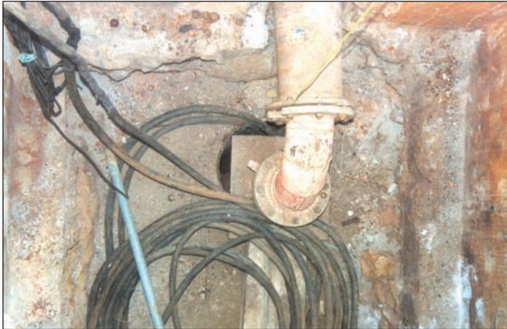
Figura 57. Una deficiente instalación puede llevar aparejada problemas de contaminación y deterioro de la misma captación (foto Vicente Fabregat).
