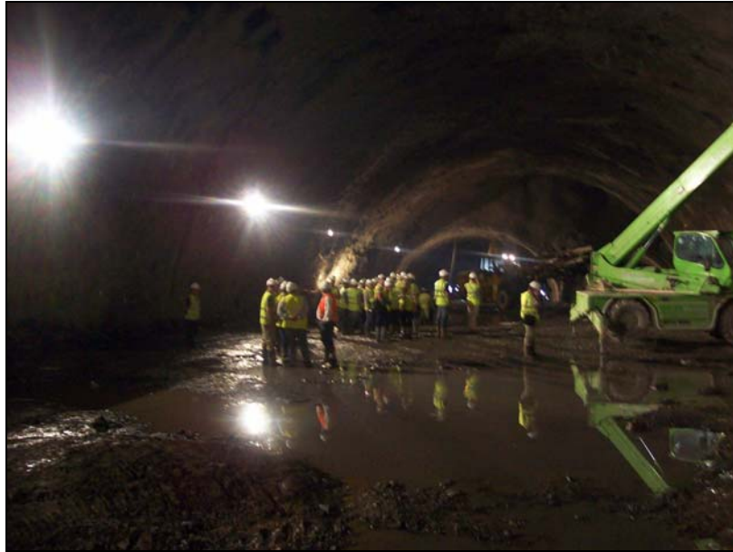
Foto 5. Reconocimiento interior de uno de los túneles
