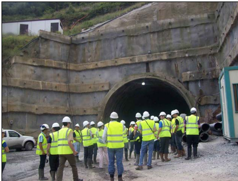
Foto 7. Entrada a uno de los túneles de de la VSM
