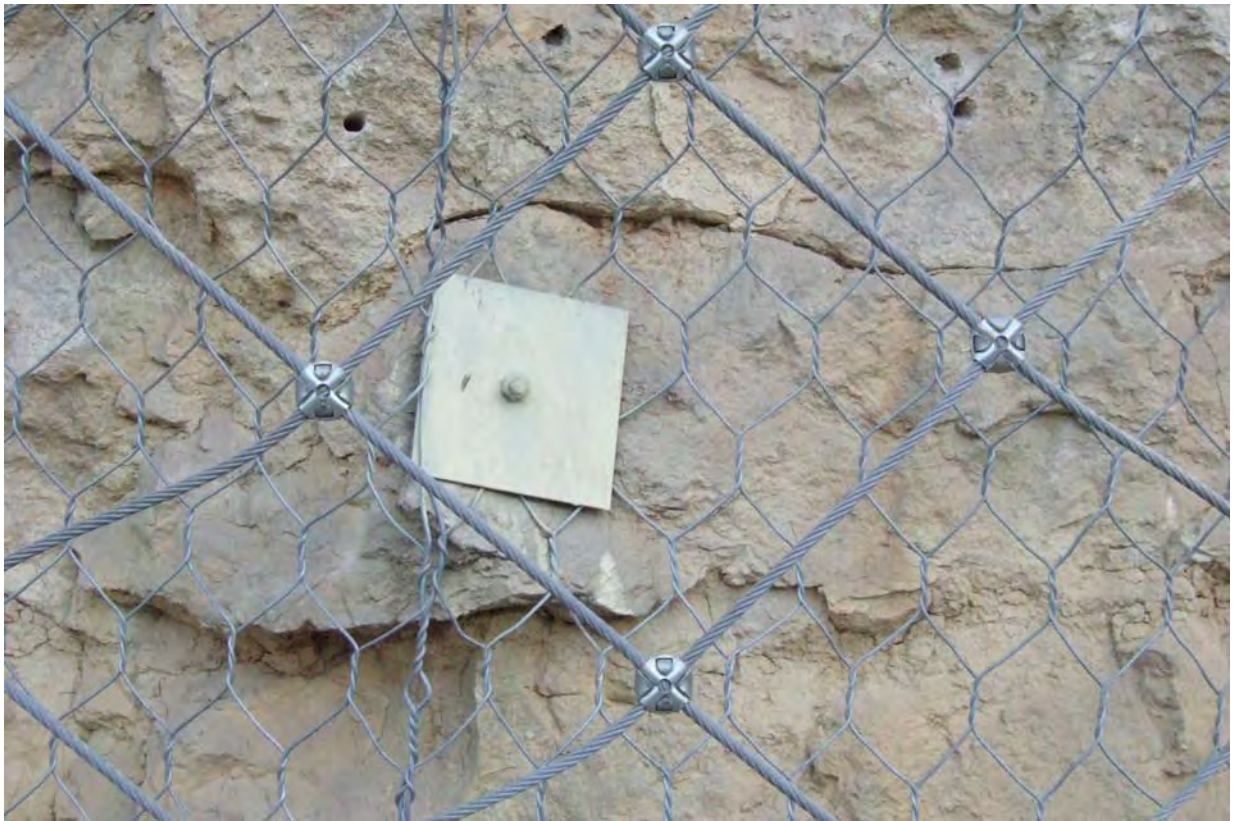
Diferentes tipos de fijaciones de los taludes instalados en la Cuesta de los Hoyos, como bulonado con placas metálicas, y mallas de triple torsión de diferentes formas y pasos.
