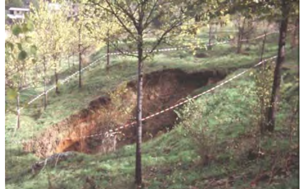
Vista lateral del mayor de los colapsos de la Cuesta de Santa Lucía.
