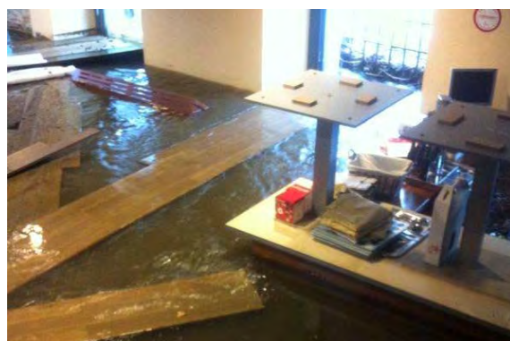
Efectos de la inundación en la planta baja del bar-restaurante Ingenio Chico, con tarima flotante de madera levantada y los elementos del mobiliario sumergidos. Fuente: Segovia al Día. www.segoviaaldia.es Autor: Javier López Alarma.
