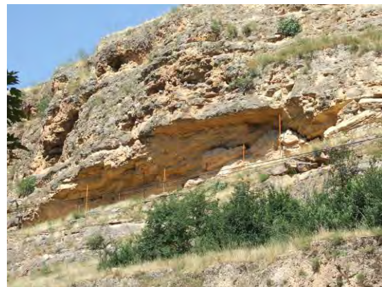
Zona próxima al arco de la Puente Castellana, cortada por desprendimientos en julio de 2008 (izquierda), y cornisa volada con simples puntales de sujeción (arriba).
