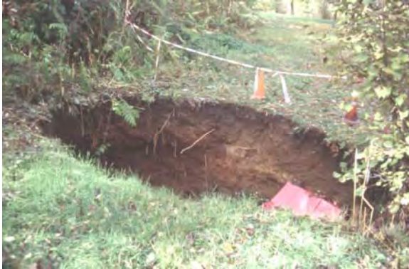
Vista lateral del menor de los colapsos de la Cuesta de Santa Lucía.
