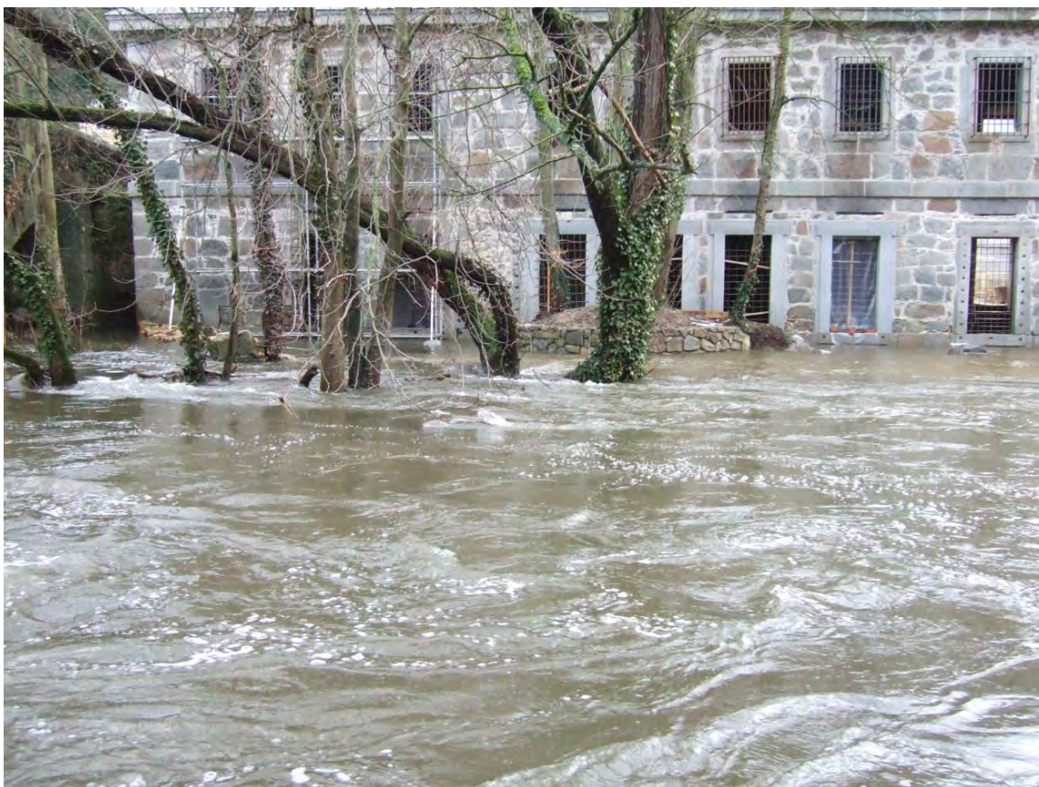
El río Eresma desbordado a la altura de la Casa de la Moneda, inundando el edificio del Ingenio Chico en la margen izquierda. 29 de enero de 2009.
