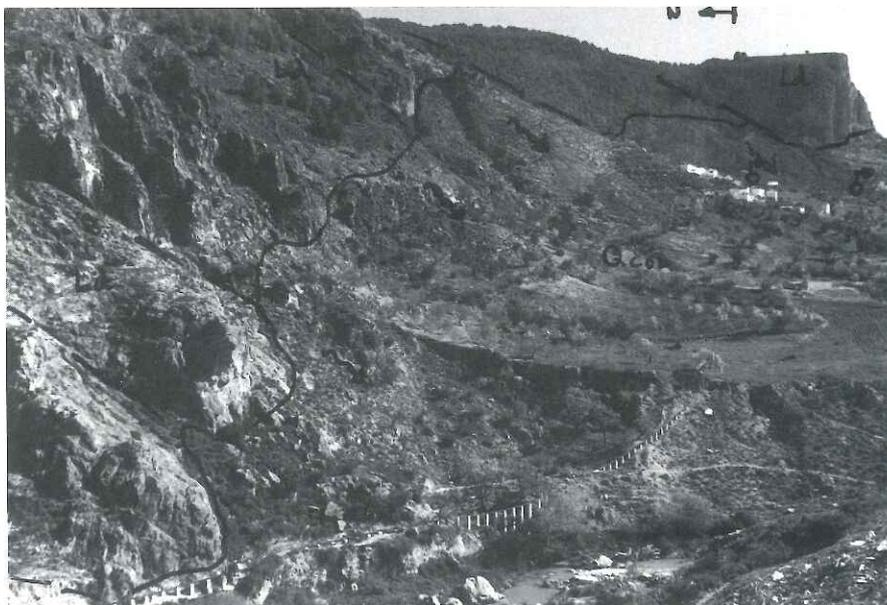
Zona de debilidad Geotécnica en el contacto litológico calizo-dolomítico y de confluencia de distintas fracturas. Los depósitos y derrubios de ladera se deslizan fácilmente hacia el eje del río Velillos.
