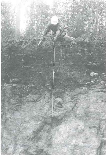
Fig. 4. Desmante mostrando el suelo edáfico, el xabre, y el granito fisurado.
