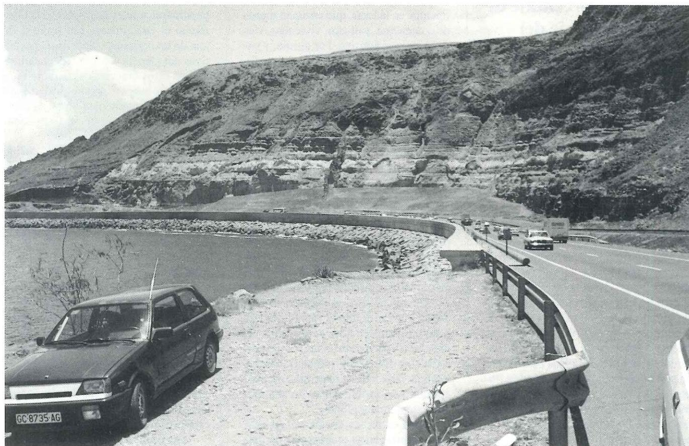
Estabilización de un cantil con riesgo de deslizamiento y desprendimientos mediante un espaldón. El Rincón, cerca de Las Palmas de Gran Canaria.
