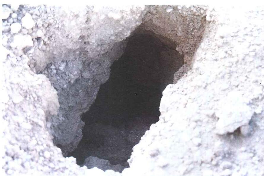
Figura 8.- Detalle de una de las oquedades que aparecen en el fondo de la excavación, a cotas de la rasante.
