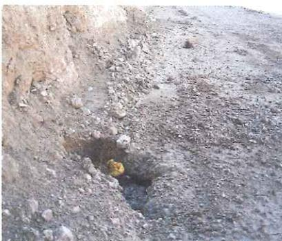
Figura 6.- Pequeño hundimiento al pie del talud de la excavación.
