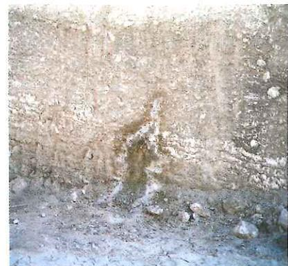
**Figura 1.- Pequeño flujo de agua a través de diaclasas en los materiales Miocenos, es fácilmente detectable por la orla de sales dejadas por evaporación.**
