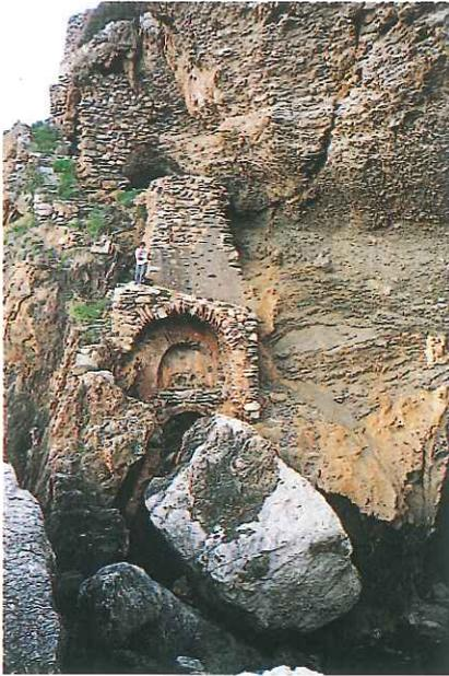
Figura 3.-Situación del talud donde se sitúan los molinos. Detalle inestabilidad: desprendimiento de bloques, cuevas, desplomes...
