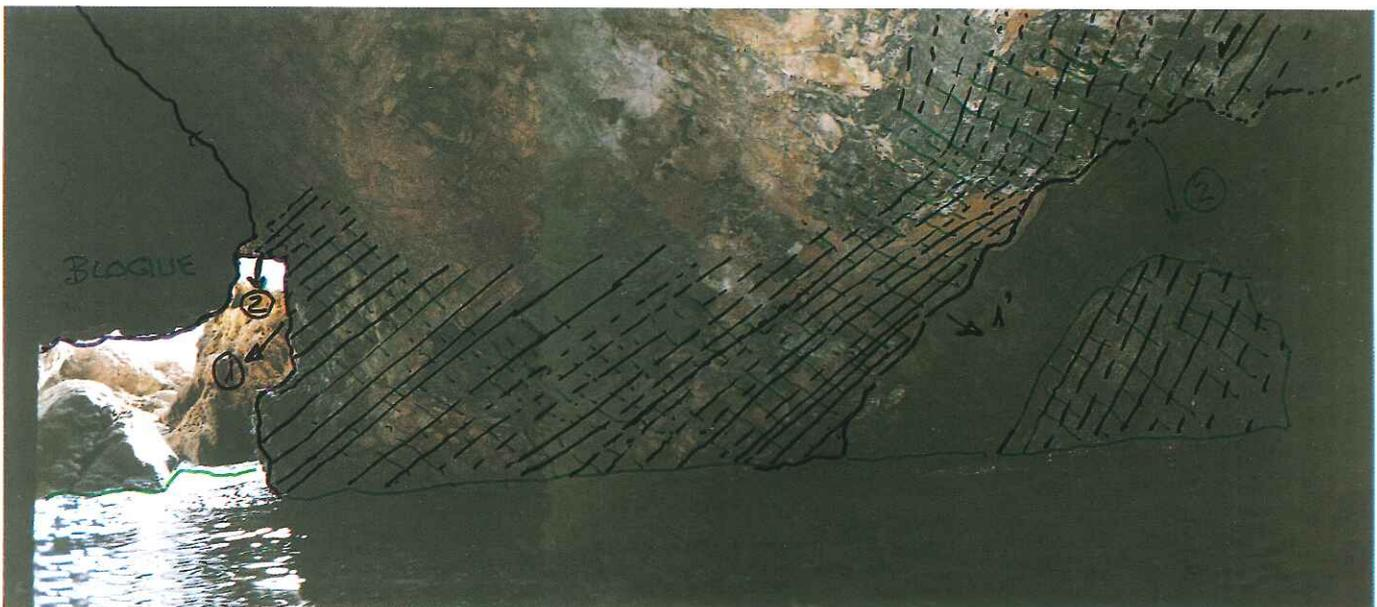
Figura 4.-Cueva donde se midió la fracturación: afecta a la base del talud.
