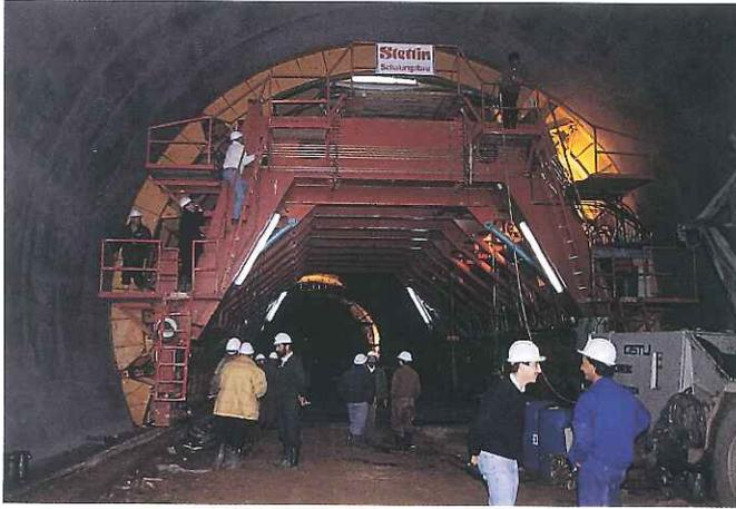
Fig. 5. Revestimiento de hormigón con carro de encofrado.
