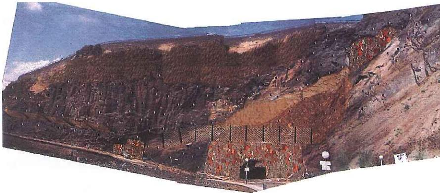
Figura 1. Simulación con ordenador sobre fotografía de algunas actuaciones: Mallas metálicas (arriba y derecha), buniones, gunitado y barrera dinámica (sobre el túnel) en el espolón de Mosa del Mar en el NE de la playa de la Arena.
