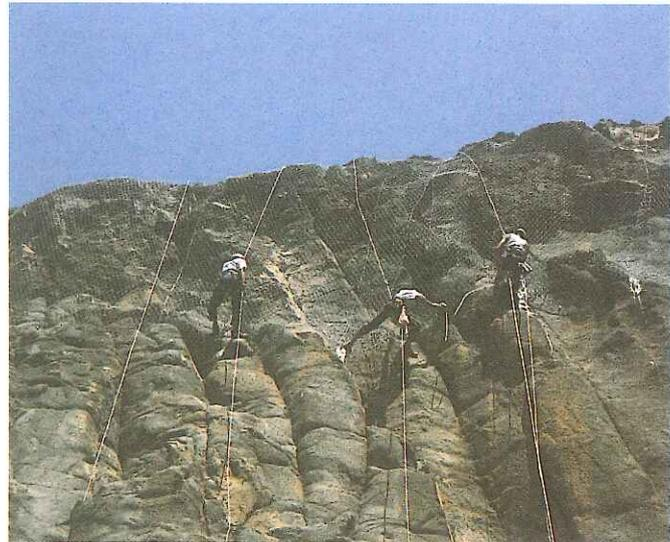
Figura 6. Trabajos verticales realizados por especialistas. Colocación de mallas.
