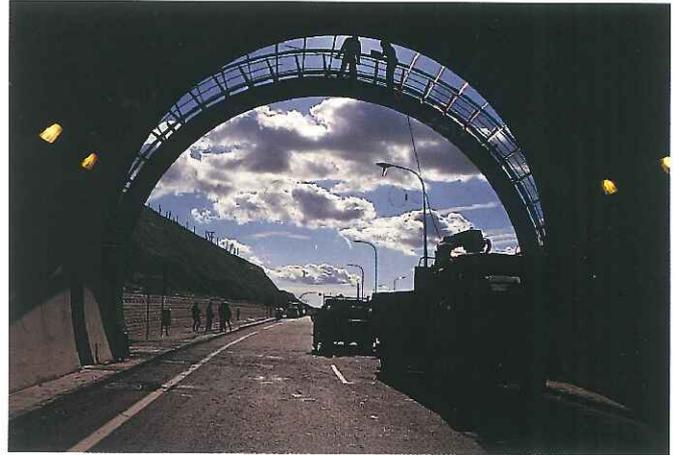
Fig. 6. Colocación de "embellecedor" en las boquillas.
