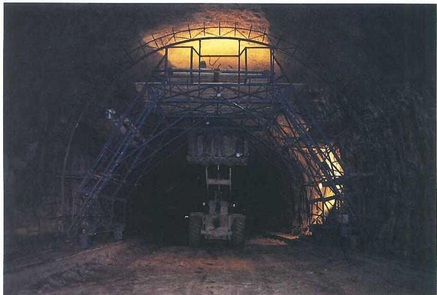
Fig. 4. Carro marcador de gálibo.
