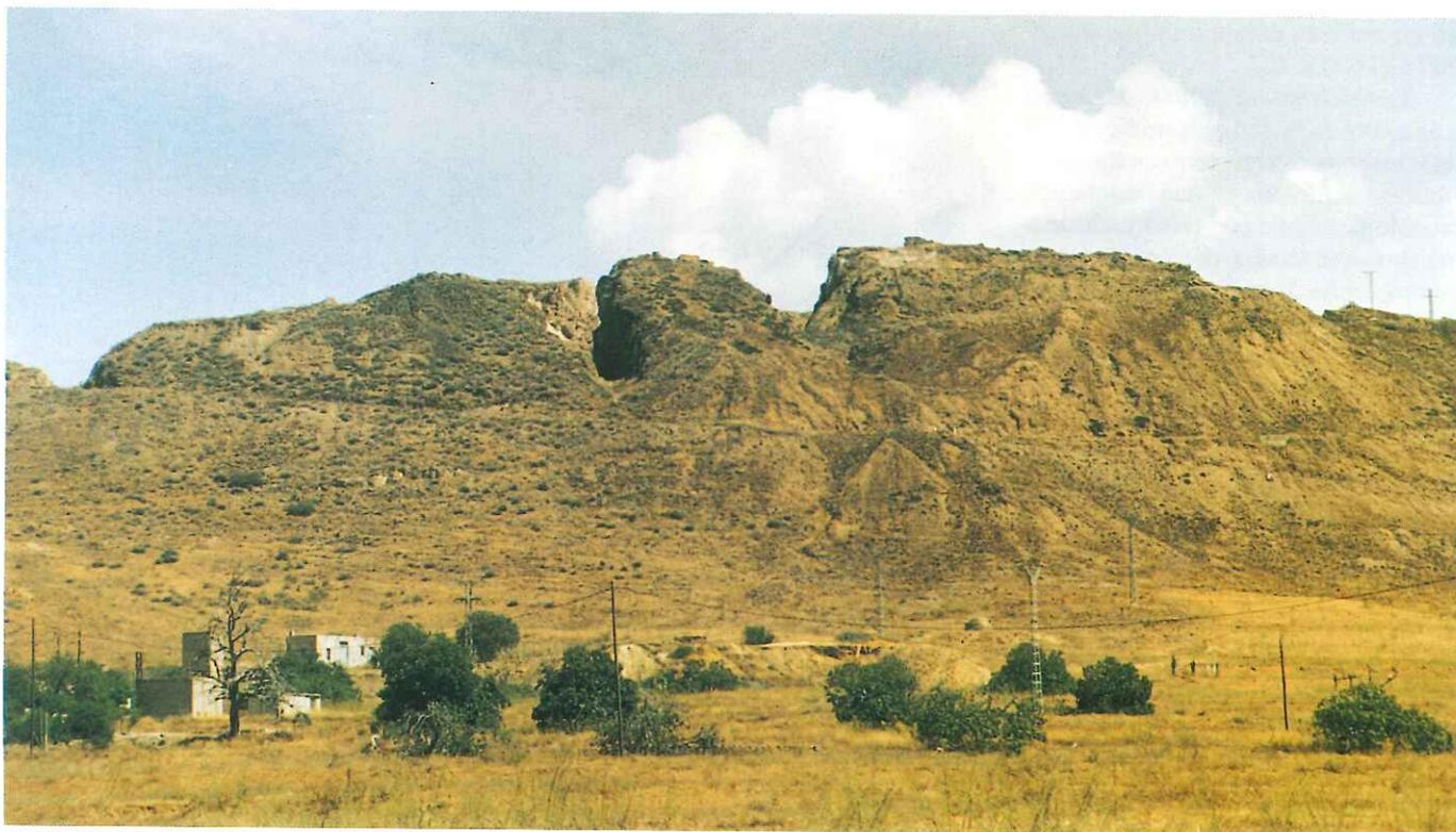
Figura 8.-Grandes hendiduras correspondientes a la explotación del filón de “La Raja” o “La Zaja”, en el “Cabezo Rajado” (Cartagena). De dirección NO-SE, fue explotado en la antigüedad hasta una profundidad de 450 metros. (Foto Manuel Rolandi).
