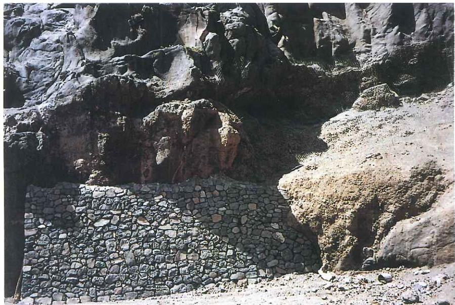
Figura 3. Muro de recalce que junto a los piroclastos están bajo las coladas basálticas.
