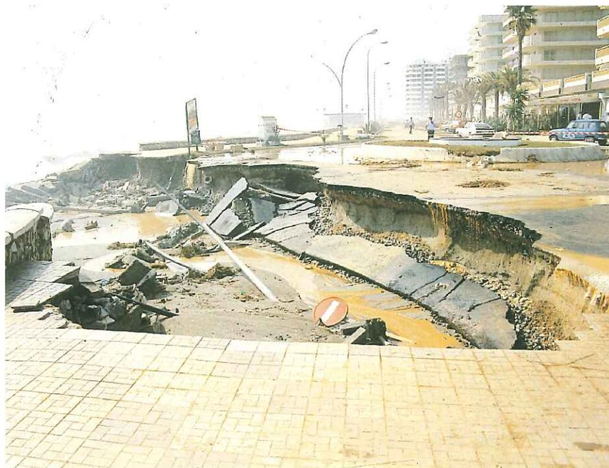
Hundimiento del paseo marítimo de Fuengirola (Málaga), causado por la combinación de una inundación y el fuerte oleaje.
