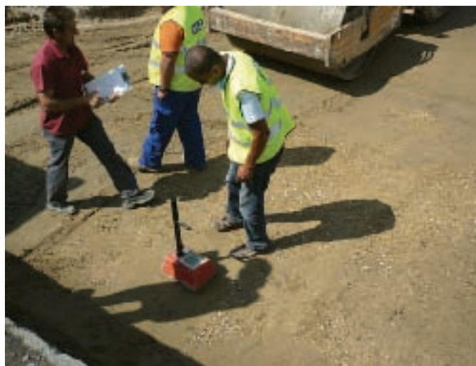
Figura 16. Formación del terraplén nuclear mediante vertido y compactación de áridos finos mezclados con cemento (imagen izquierda). Se realizan tongadas de poco espesor que se ensayan para controlar la densidad mediante un equipo nuclear (imagen derecha). Sobre este terraplén se colocará el subbalasto y el balasto.
