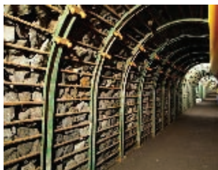
Figura 14. Primeros metros de la galería de la Fuente Santa perforados con el método de escudo. Consiste en ir colocando redondos de hierro en el techo para sujetar las escorias hasta lograr excavar por debajo un metro de galería. Allí se ponía una nueva cercha que son los arcos verdes que se aprecian en la foto. El siguiente paso era colocar los redondos de hierro uniendo las cerchas y se acababa dejando las piedras más grandes, sacadas de la excavación, por detrás de estos redondos y así sujetar los materiales más pequeños para que no caigan en la galería. El resultado final es el que se aprecia en la foto; de esta forma se puede ir viendo el material que se ha ido excavando.
