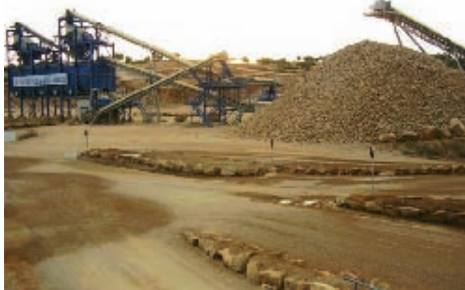
Figura 14. Planta de tratamiento.
