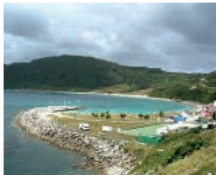
Figura 1. Algunas construcciones, formadas por acumulación directa de áridos de gran tamaño, como este puerto de Estaca de Bares, remontan su origen a la época fenicia.
