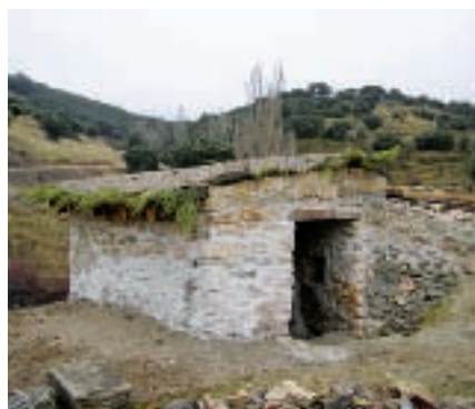
Figura 7. "Portal" del horno Z-1-B reconstruido según el aspecto original siguiendo las indicaciones de los que lo vieron en uso. Se aprecia la cubrición formada por rollizos que soportan un entramado de retama cubierto por una capa de barro.
