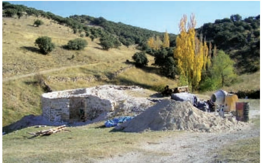
Figura 6. Vista del portal del horno Z-1-B durante el proceso de restauración. Se aprecia el "portal" aún sin cubrir y los rollizos de madera que emplearán para tal fin al fondo.
