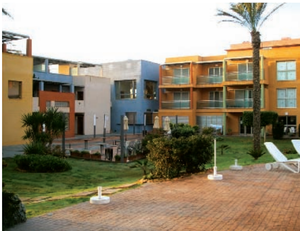
Figura 1. Edificaciones con el acabado exterior en mortero monocapa.
