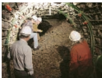
Figura 20. Una vez alcanzado el acantilado antiguo se comenzó a abrir el ramal de galería en el hastial derecho; era un momento delicado por la gran inestabilidad del material. Aun con todas las precauciones y con la seguridad de ir despacio, se produjo el derrumbe en el interior de la galería de la Fuente Santa, concretamente en la zona donde comienza el ramal. En primer término, de espaldas y a la derecha, José Manuel Navarro, geólogo, y, a la izquierda, Julián Mansilla, ingeniero y jefe de obra de SATOCAN. Al fondo, en primer lugar, Miguel Ángel Sicilia, y, detrás, Carlos Soler Liceras, ayudante y director de la obra, respectivamente, y ambos de la Dirección General de Aguas de la Consejería de Infraestructuras, Transporte y Vivienda del Gobierno Autónomo de Canarias.
