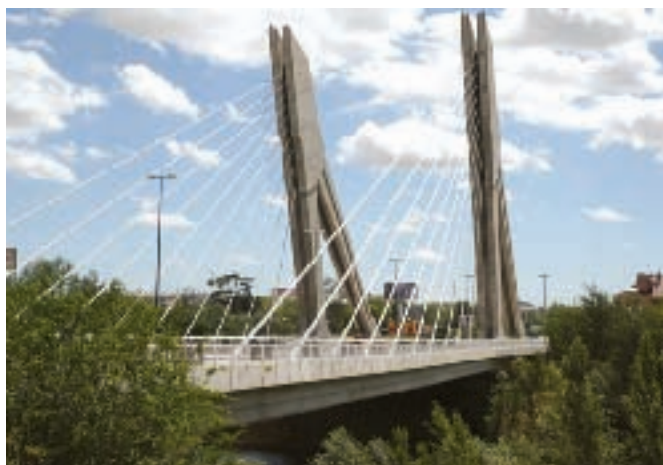
Figura 19. Puente de la Hispanidad (Valladolid). La utilización de hormigones de alta resistencia (HAR) permite realizar obras de diseños técnicos cada vez más complicados.
