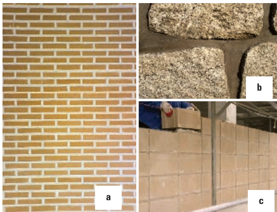
Figura 5. Mortero para fábrica de albañilería en tres situaciones: (a) entre ladrillos, (b) entre bloques de granito y (c) entre bloques de cerramiento de hormigón.
