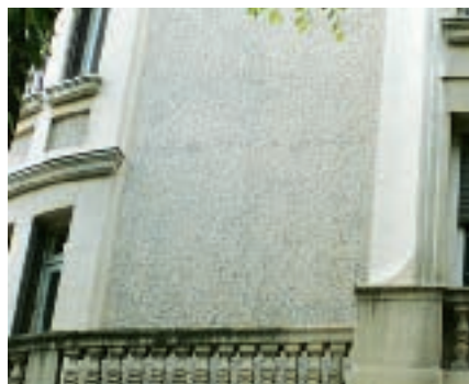
Figura 6. Esgrafiado en una fachada.
