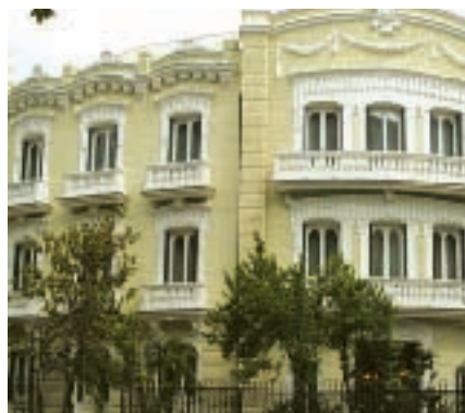
Figura 2. Fachada con un acabado de mortero de revoco.
