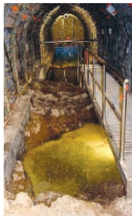
Figura 22. Vista del final del ramal. En primer término aparece la surgencia de la Fuente Santa y se aprecia por el color ocre la precipitación de aragonito; tras ella aparece el dique volcánico y, más al fondo, la piscina subterránea donde el agua se enfría hasta los 30°C.
