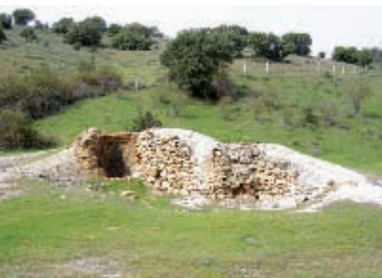
Figura 4. Horno doble Z-3 tal como estaba antes de la intervención, con las cámaras semihundidas y el "portal" totalmente enterrado.
