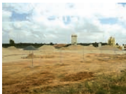
Figura 4. Planta provisional de elaboración de hormigón montada en las inmediaciones de un tramo de AVE. Se pueden apreciar los acopios de áridos de distintos tamaños.
