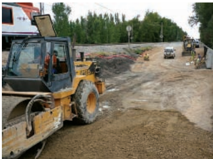
Figura 16. Formación del terraplén nuclear mediante vertido y compactación de áridos finos mezclados con cemento (imagen izquierda). Se realizan tongadas de poco espesor que se ensayan para controlar la densidad mediante un equipo nuclear (imagen derecha). Sobre este terraplén se colocará el subbalasto y el balasto.
