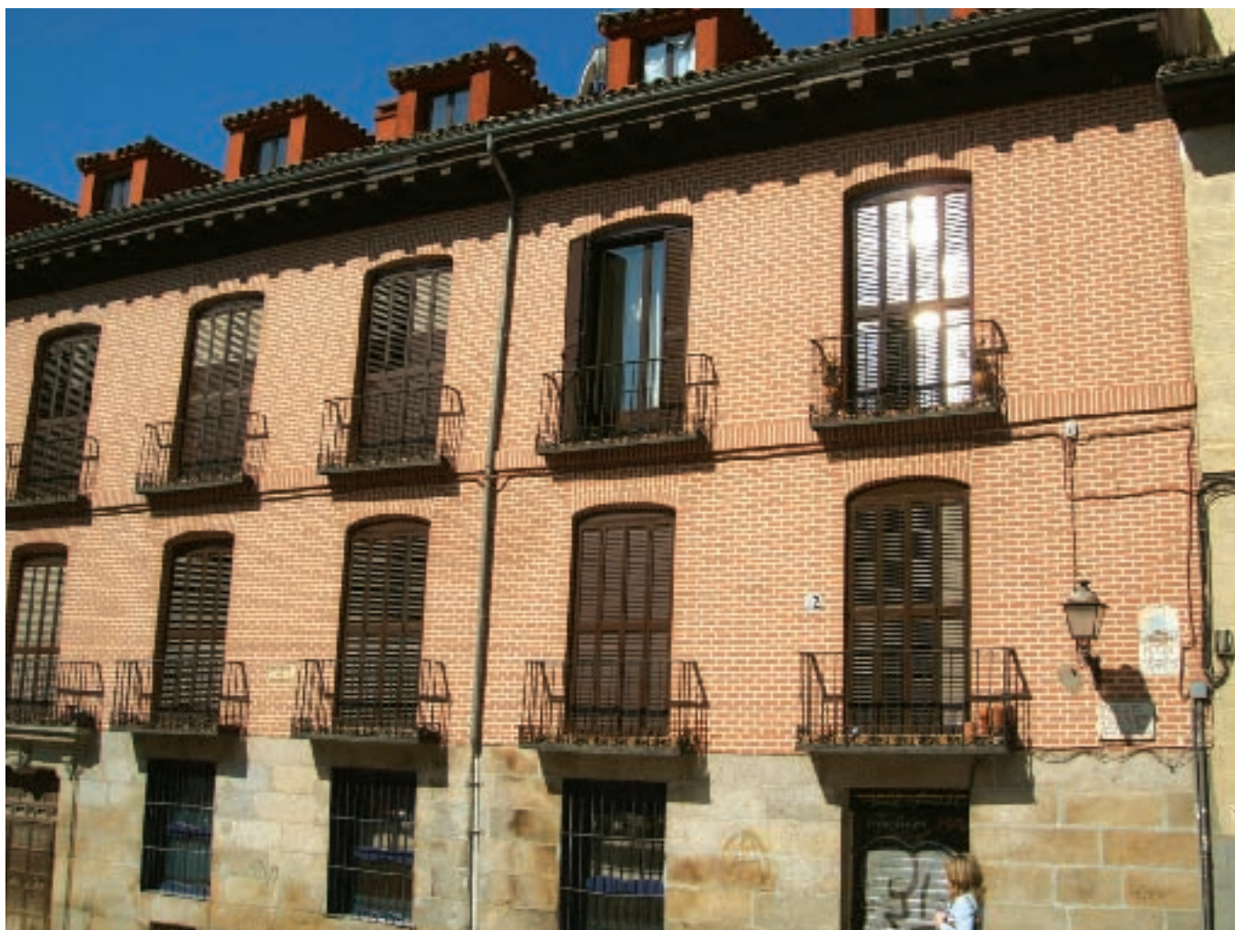
Figura 8. Revoco liso imitando una fábrica de ladrillo.
