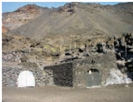
Figura 13. Vista del emboquille de la galería y del cuarto donde se guarda la maquinaria. Al fondo pueden apreciarse los restos del acantilado pre-San Antonio y de la avalancha que sepultó la Fuente Santa.
