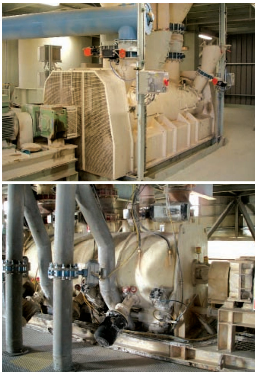
Figura 4. Mezcladoras de los componentes del mortero.
