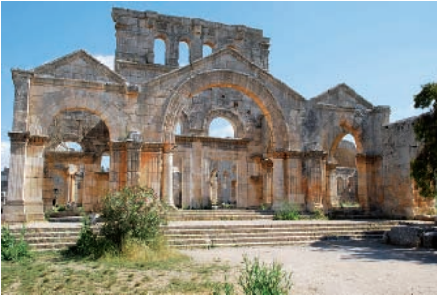
Figura 4. Fachada principal de la basílica de San Simeón.
