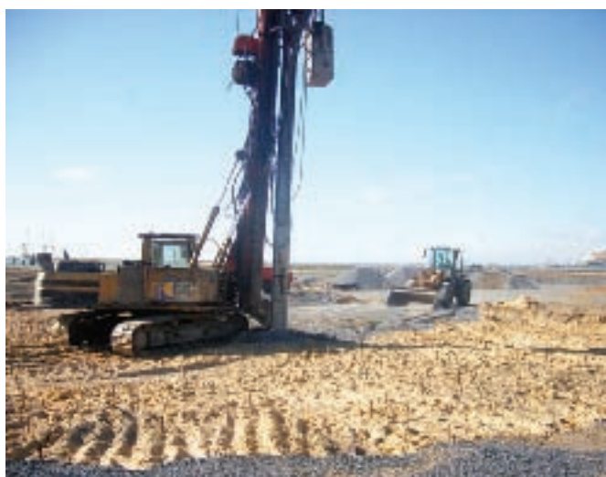
Figura 17. Ejecución de columnas de grava. Esta técnica fue desarrollada por KELLER y, con el tiempo, ha ampliado su campo de actuación a prácticamente todos los tipos de "suelos". En la imagen se ve el vibrador que se encargará de realizar el hueco.
