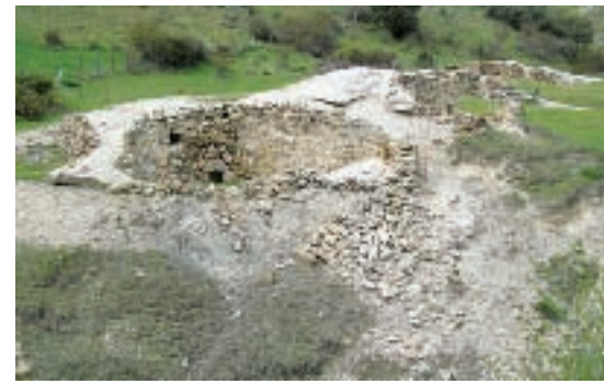
Figura 3. Vista general desde el este antes de la intervención en la que se observan los muros desplomados y los túmulos erosionados. El horno en primer plano es Z-1-A con su "portal" derrumbado.
