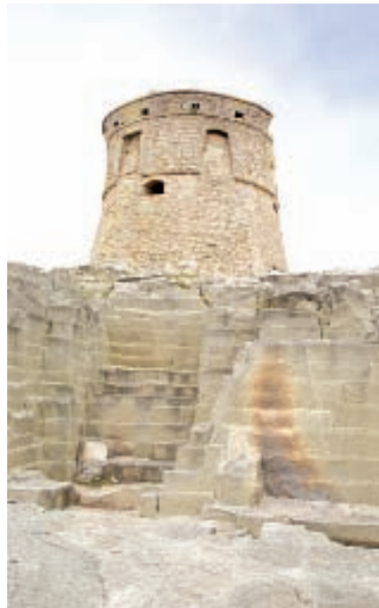
Figura 3. Torre defensiva di Porto Miggiano (Santa Cesarea, región de Apulia, Italia), construida con la piedra extraída de las canteras infrayacentes.
