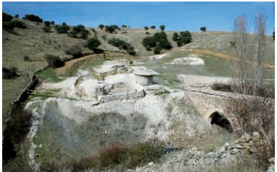
Figura 1. Vista general desde el este con la intervención muy avanzada. En primer plano, el acueducto con su canal reparado y en el conjunto de hornos pueden apreciarse las consolidaciones y la adecuación del terreno.
