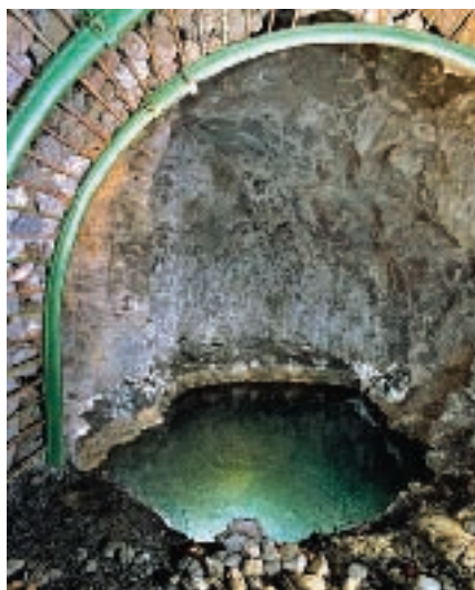
Figura 16. Piscina del primer anchurón durante la fase de construcción; las manchas blancas en las grietas del basalto proceden de los gases volcánicos de las coladas. El agua de la piscina está a 30°C y precipita calcita en forma de una delgadísima película superficial que flota durante el tiempo en el que el nivel de agua desciende camino de la bajamar. Cuando sube, momento de la foto, esta película se precipita hacia el fondo, engrosando una capa de barro finísimo. Antiguamente le asignaban a este barro propiedades curativas y rejuvenecedoras.
