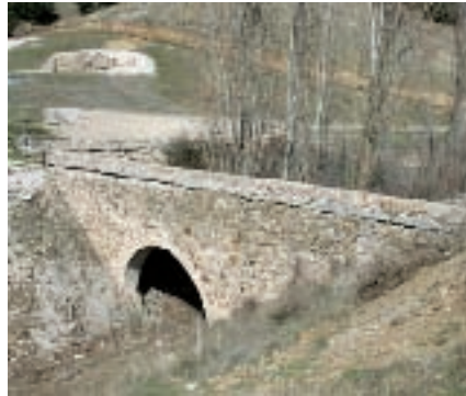
Figura 10. Vista del arco del acueducto del Zancao con la calera en segundo plano. Se aprecian las dos canalizaciones superpuestas con las losas de la original repuestas en posición transversal; la parte donde gira en ángulo recto ha sido restaurada.
