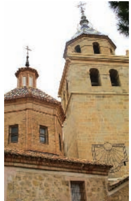
Figura 4. Materiales geológicos empleados en la arquitectura de Albarracín (Teruel). Sobre la piedra caliza se ha aplicado una pátina, y, en las construcciones, se utiliza también el ladrillo, la cerámica, el mortero e incluso el alabastro.
