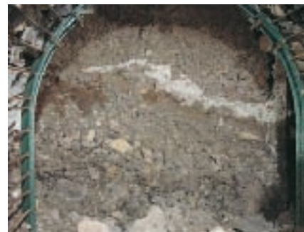
Figura 15. Foto del frente donde pueden apreciarse las piedras que sepultaron la Fuente y su falta de cohesión, que se traducía en una gran inestabilidad. Las piedras blancas de la parte inferior son los callaos de playa de la antigua costa. La creciente inestabilidad del material obligó a cambiar de procedimiento, se abandonaron los piquetes y la perforación en escudo para pasar a inyectar la clave de la galería mediante cinco sondeos por donde se introducía agua y cemento que, al fraguar con las escorias y los propios tubos de inyección, convertían el techo en una cúpula de hormigón armado. La mancha alargada y blanquecina en el centro de la foto es el cemento de las inyecciones de consolidación, gracias a ellas se consiguió que las piedras disgregadas se mantuvieran estables hasta que lográbamos colocar la cercha de hierro pintada de verde que se aprecia en la foto.
