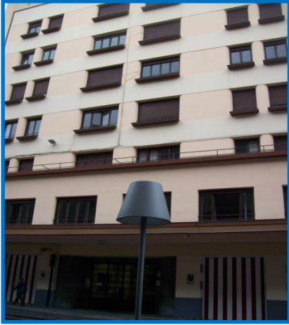
Fachada del edificio donde se localiza la nueva sede de la delegación.
