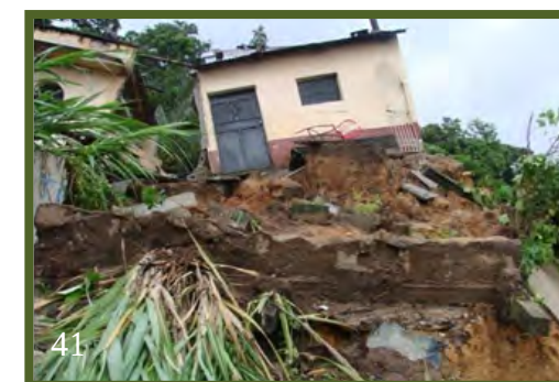
Deslizamientos de tierra provocados por las tormentas tropicales.
