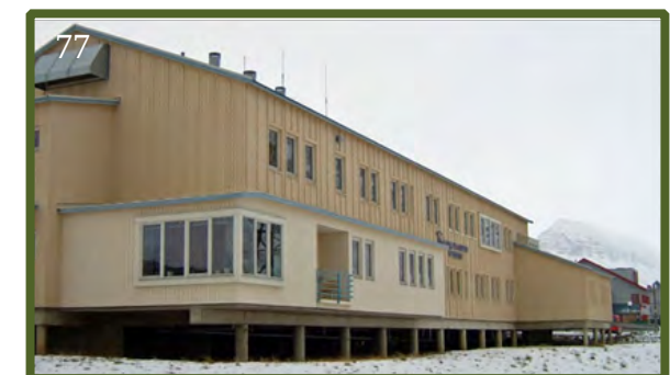
Pilotes: Solución ingenieril para este hospital asentado sobre permafrost.
