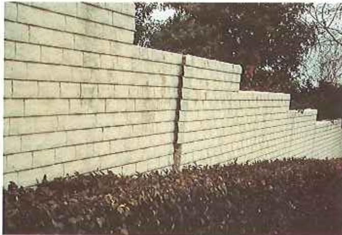
Los empujes de los suelos expansivos han causado que esta pared de bloques que rodea a una propiedad se incline y rompa. (Foto de Edward Nuhfer).
