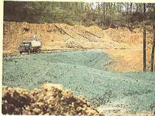
(2) La sustitución del suelo vegetal es seguida rápidamente por el sembrado, para establecer una cubierta vegetal. En la imagen una hidrosembradora extiende una mezcla de semillas y fertilizante junto con una capa de paja. El color verde procede de un tinte biodegradable que permite al operario de la hidrosembradora apreciar la cobertura.
