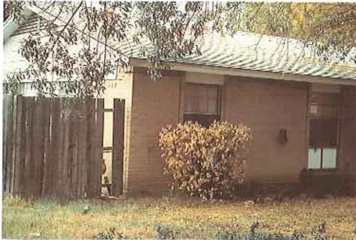
El abombamiento de los suelos expansivos ha dañado esta casa de Texas, causando una separación cerca del techo. (Foto de Edward Nuhfer).
