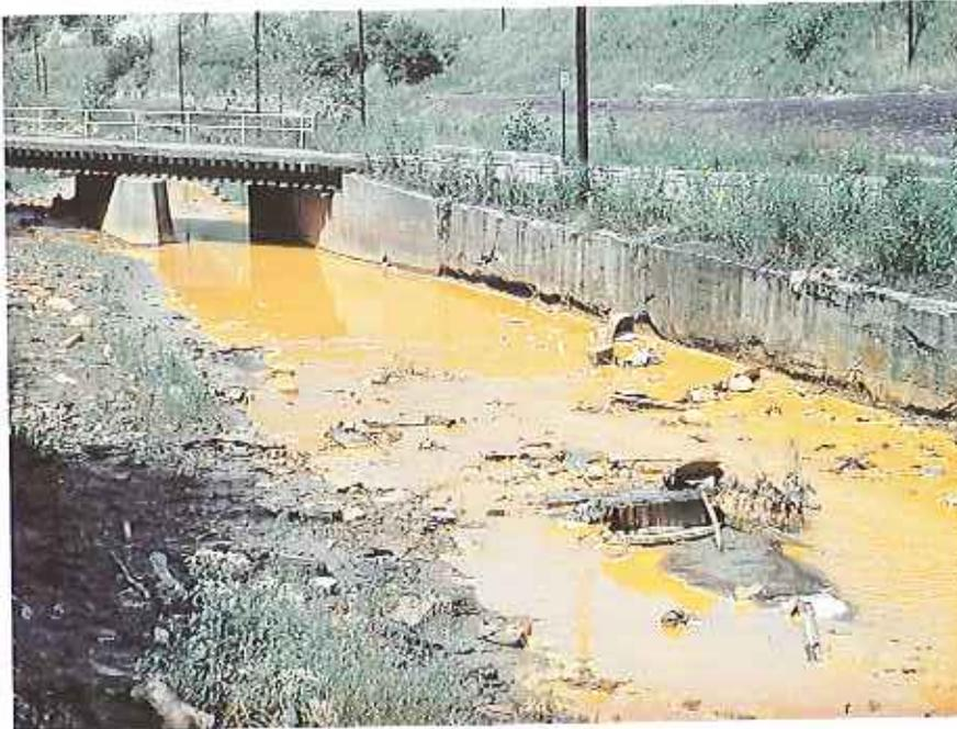
El drenaje ácido procedente de viejas minas de carbón produjo los lodos del arroyo. Las aguas ácidas corroyeron el muro de retención de cemento y los pilares del puente que se observan seguirán pronto la misma suerte. La restauración y las prácticas mineras actuales minimizan el drenaje ácido. Las minas a cielo abierto modernas causan muy pocas veces estos efectos. (Foto del Servicio Geológico y Económico de Virginia del Este).
