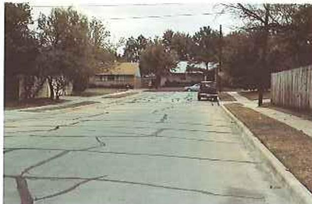
Las carreteras construidas sin tomar las debidas precauciones con respecto a la existencia de suelos expansivos muestran abombamientos, ondulaciones y multitud de grietas. (Foto de Edward Nuhfer).
