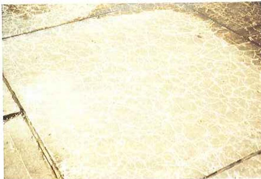
El agrietamiento de este hormigón revela una reacción expansiva entre el ácido y el cemento en el hormigón. Pronto la superficie se llenará de desconchones a lo que seguirá el completo deterioro. (Foto de Edward Nuhfer).
