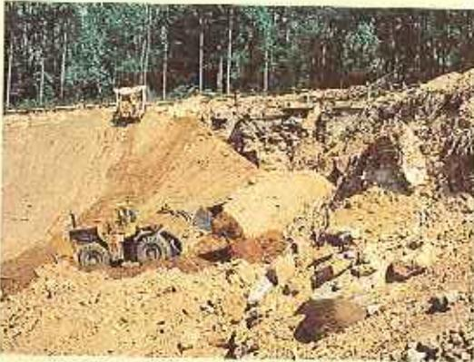
(1) El drenaje se desvía y controla continuamente desde la zona alterada. La adecuada reposición de los estériles recubiertos por el suelo y a su vez por el suelo vegetal, asegura taludes estables y el enterramiento de cualquier posible mineral reactivo. Esta pala está compactando ligeramente el suelo al dejar sus cadenas unas marcas alineadas que aplanan la pendiente y sujetan las semillas y la humedad.
