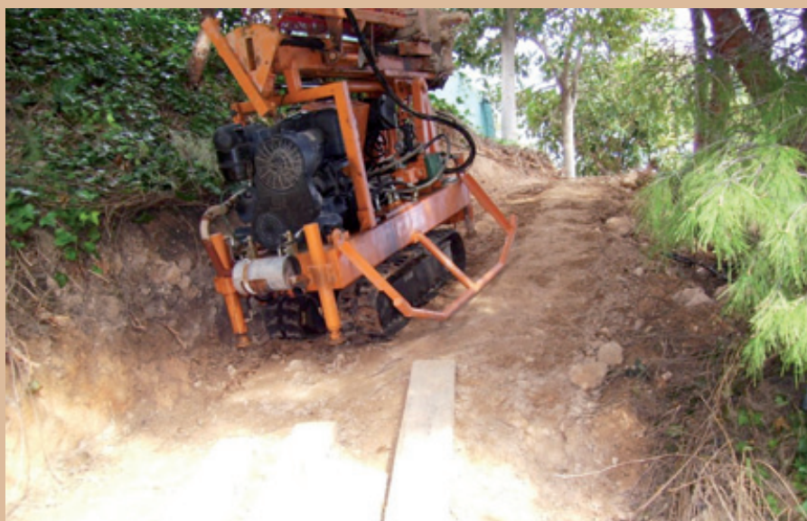
Figuras 18.A y 18.B. Subida de rampa "acondicionada" de 42º, con ayuda de cabrestante manual para realizar un sondeo geotécnico de 28 metros en un talud de patología de la figura 1.A.
