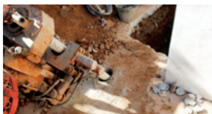
Figuras 4.C y 4.D. Perforación de solera de la vivienda, atravesando materiales con un ángulo de unos 30° y batería simple atravesando materiales en la calicata realizada.
