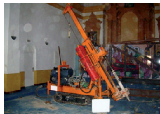
Figura 6.A. Sondeo inclinado en una iglesia para obtener el dato de la anchura de zapata, procediendo a la perforación lateral de la misma.
