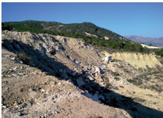
Figura 2.A. Talud donde se tiene previsto emplazar una urbanización en la que se han vertido rellenos antrópicos no controlados.
