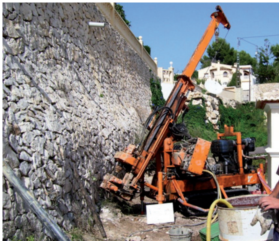
Figura 7.A. Sondeo inclinado en un muro para la detección de materiales presentes en el trasdós, en el que se tiene limitación en anchura y de maniobrabilidad de ejecución del mismo.
