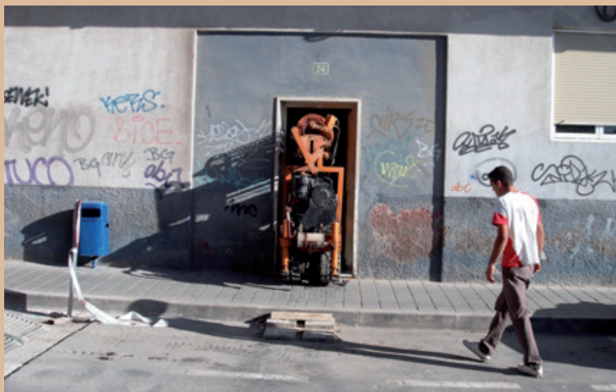
Figuras 14.A y 14.B. Edificio que presenta una patología y precisa de un estudio geotécnico para realizar un ascensor que presenta limitación tanto en anchura como en altura. Máquina entrando en dicho zaguán con entrada de 0,73 metros.
