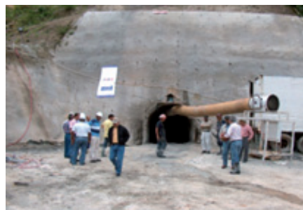
Figura 7. Boca de acceso al túnel de explotación del larimar, en Barahona.
