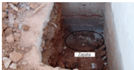
Figura 4.A. Debido a la antigüedad de las viviendas (1 y 2), se carece de planos de cimentación, por lo que se realiza calicata manual para detección de zapata, evitando, de esta manera, la perforación de la misma. En este caso, se conocía el canto de la misma (z), ignorando el resto de dimensiones (x-y).
