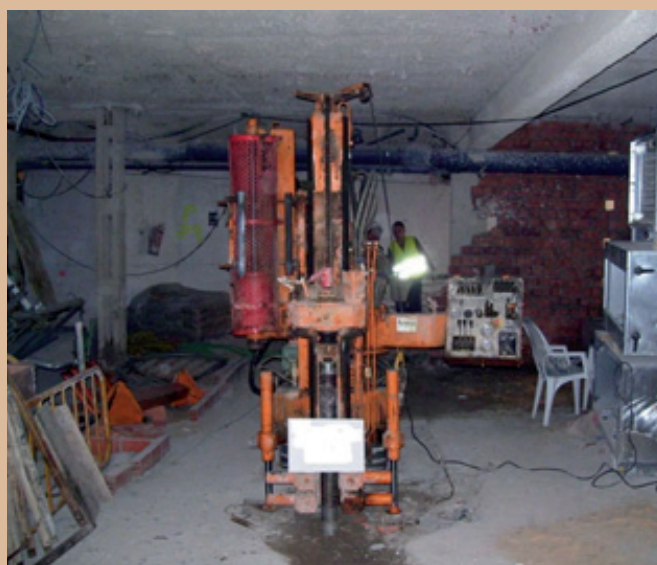
Figuras 12.A y 12.B. Sondeo en el sótano de un hotel, en condiciones extremas, donde se aprecia una manguera de extracción de humos de 3", usada en minería.
