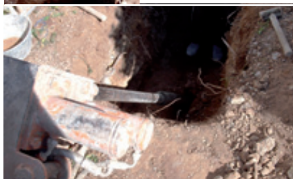
Figuras 5.B, 5.C y 5.D. Máquina de sondeos perforando directamente en la calicata con un ángulo de unos 30° y vista inferior del operativo de sondeo desde la calicata.
