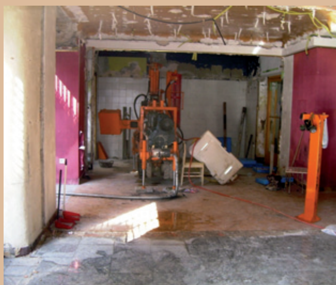
Figuras 13.A y 13.B. Edificio a rehabilitar con entrada de 2,60 metros de altura y 2,50 metros de anchura. Máquina realizando sondeos bajo forjado de 2,45 metros, con extensión de la torre de perforación a la derecha.
