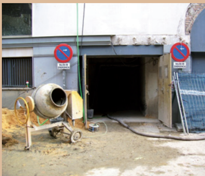
Figuras 12.A y 12.B. Sondeo en el sótano de un hotel, en condiciones extremas, donde se aprecia una manguera de extracción de humos de 3", usada en minería.
