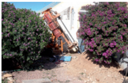
Figura 5.A. Vista lateral de una máquina de sondeos realizando sondeo inclinado para tomar una muestra de los materiales justo debajo de la cimentación.
