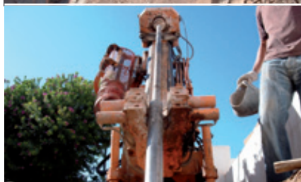
Figuras 4.C y 4.D. Perforación de solera de la vivienda, atravesando materiales con un ángulo de unos 30° y batería simple atravesando materiales en la calicata realizada.
