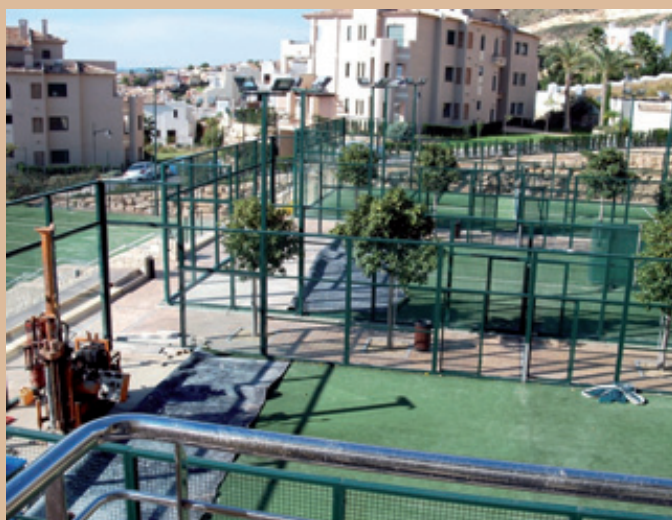
Figuras 16.A y 16.B. Campaña de campo consistente en sondeos geotécnicos para un informe patológico en pistas de pádel, en las que se tuvieron que quitar cristales laterales para su entrada.
