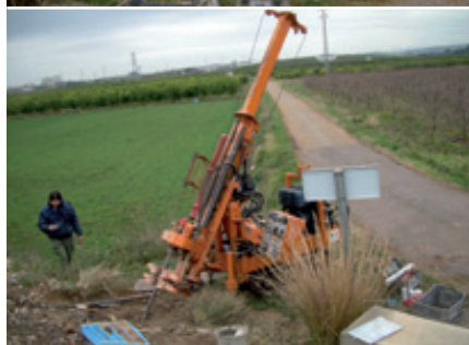
Figuras 8.A, 8.B y 8.C. Sondeos inclinados en un terraplén para validar el lecho de apoyo de una vía férrea convencional.
