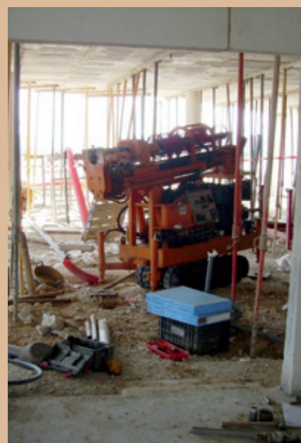
Figuras 14.A y 14.B. Edificio que presenta una patología y precisa de un estudio geotécnico para realizar un ascensor que presenta limitación tanto en anchura como en altura. Máquina entrando en dicho zaguán con entrada de 0,73 metros.
