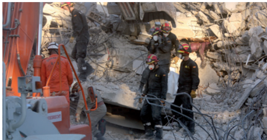
Figura 9. Los trabajos de desescombro con máquinas no se inician hasta que no se tiene la certeza de que no hay más víctimas atrapadas vivas, pendientes de ser rescatadas. Fotografía: Luismi Ortiz, Oficina de Comunicación Pública UME.
