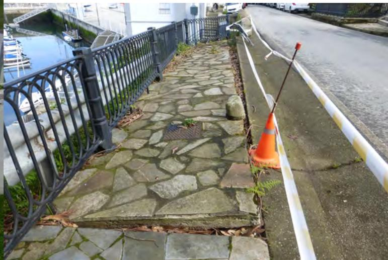
Imagen 31. Grietas y desplazamientos en aceras y viales (Figueras, Castropol)
