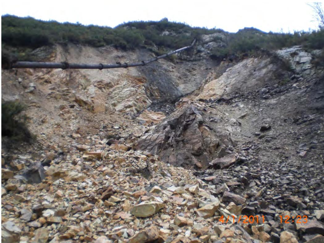
Imagen 18. Avalancha de rocas afectando a una conducción de agua y a la Senda del Alba (Sobrescobio).
