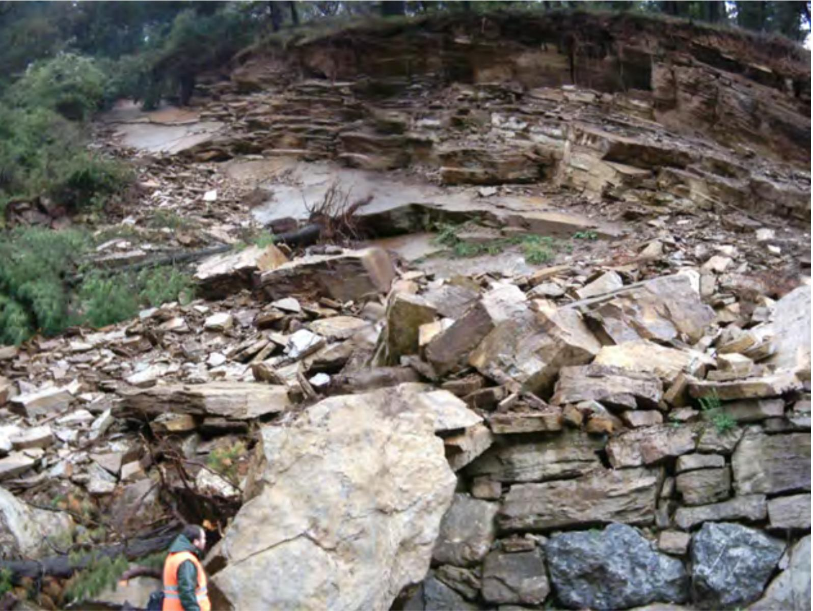
Imagen 7. Deslizamiento planar en macizo rocoso afectando a la carretera AS-15 a la altura de Argancinas (Cangas del Narcea)
