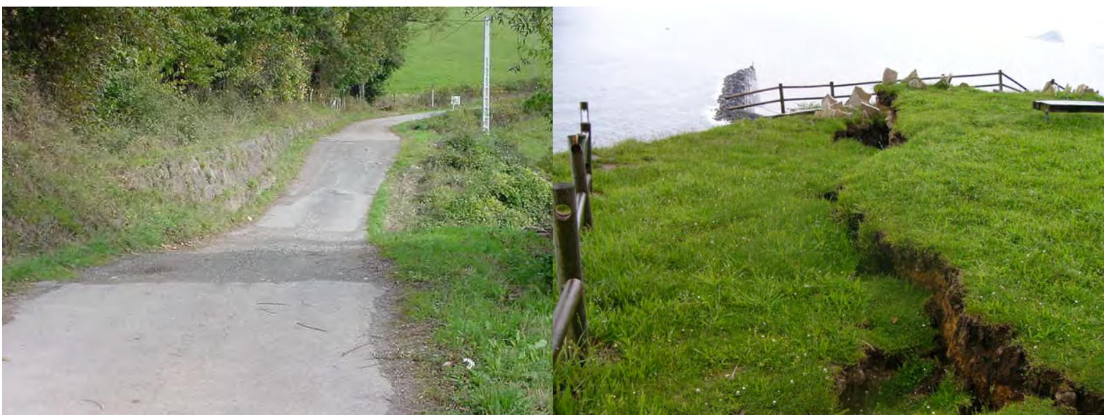
Imagen 25. Hundimientos anormales en carreteras. Picullanza (Oviedo)
