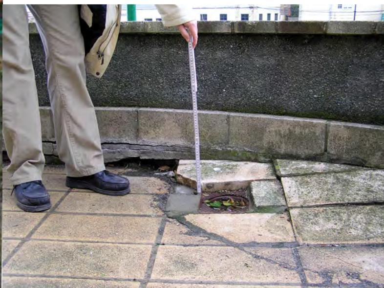
Imagen 33. Grietas y hundimientos en pavimentos y soleras. Casa del Mar de Tapia de Casariego
