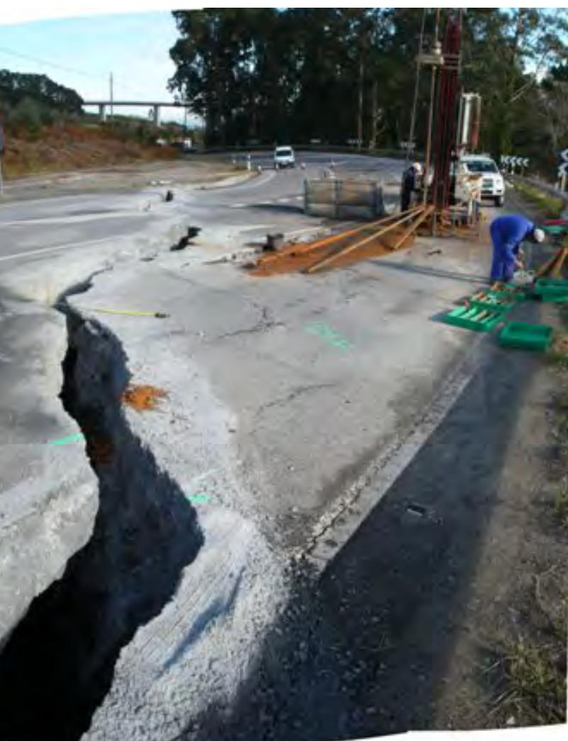
Imagen 32. Grietas en una carretera asfaltada. Alto del Praviano (Soto del Barco)
