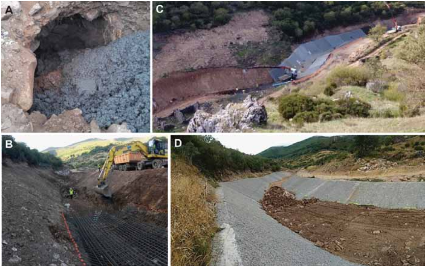
Fig. 3. Diversos aspectos de la obra. A. Relleno de los conductos kársticos; B. Excavación del canal y disposición del armado de la viga de fondo; C. Construcción de los diferentes paños de la canalización; D. Relleno del canal
