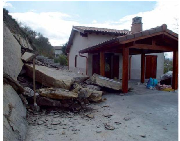
Desplome de un talud en las obras de edificación de una casa
