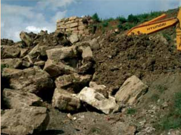
Figura 13. Caída de bloques de escollera en el frente del muro.
