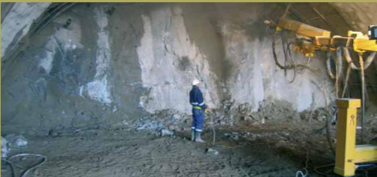
*Gunitado. Robot de gunitado por vía húmeda.*
