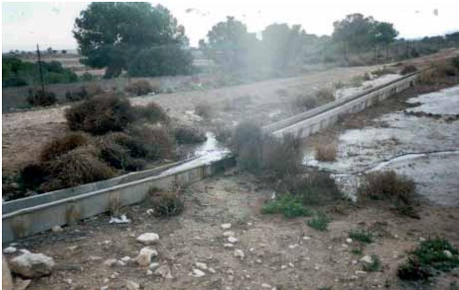
Figura 12. Debe cuidarse el estado de las conducciones, puesto que pueden producirse derrames accidentales.
