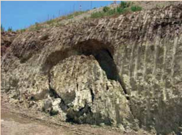
Figura 6. Desprendimiento de un talud durante la ejecución del armado del muro.
