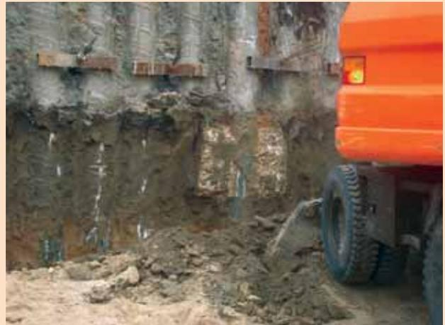
Figura 16. Pilote atravesando una cimentación antigua.
