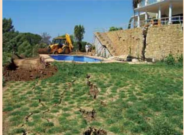
Figura 14. Destrozos provocados por un deslizamiento en una vivienda.
