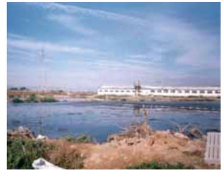
Figura 14. Balsa de gran extensión y poca profundidad rellena de purines. Se emplean, principalmente en zonas con muchas horas de sol, para favorecer la evaporación y secado de los purines.
