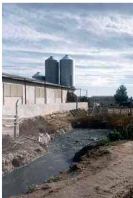
Figura 15. Fosa de purines excavado en formaciones cuaternarias.
