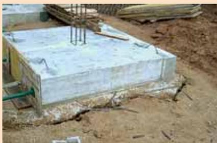
Figura 20. Descalce de zapata.
