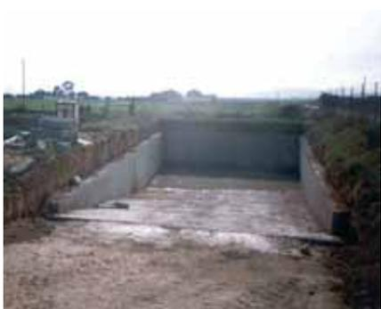
Figura 16. Dos fosas, una sin impermeabilizar y la otra con impermeabilización de hormigón.
