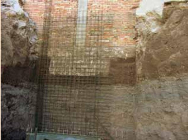
Figura 4. Batache dejando al descubierto una zapata.
