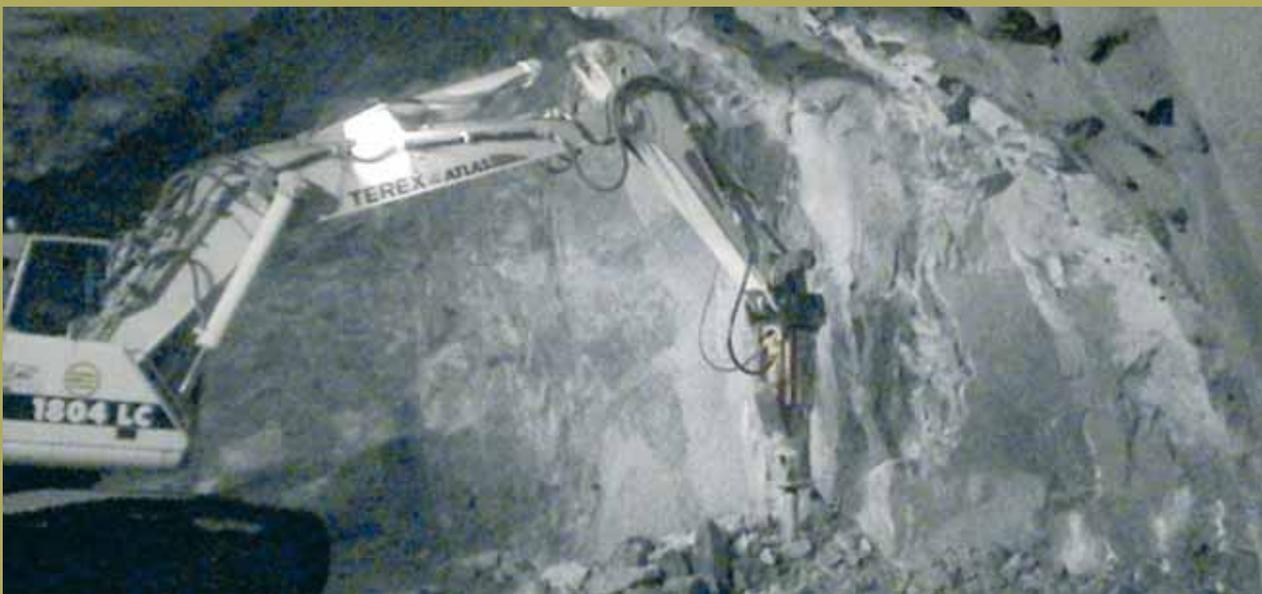
Saneo de la sección. Martillo picador montado sobre retroexcavadora.
