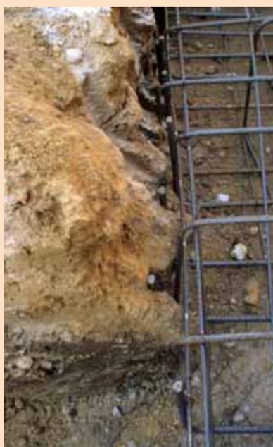
Figura 24. Ausencia de recubrimiento en la armadura de la zapata.
