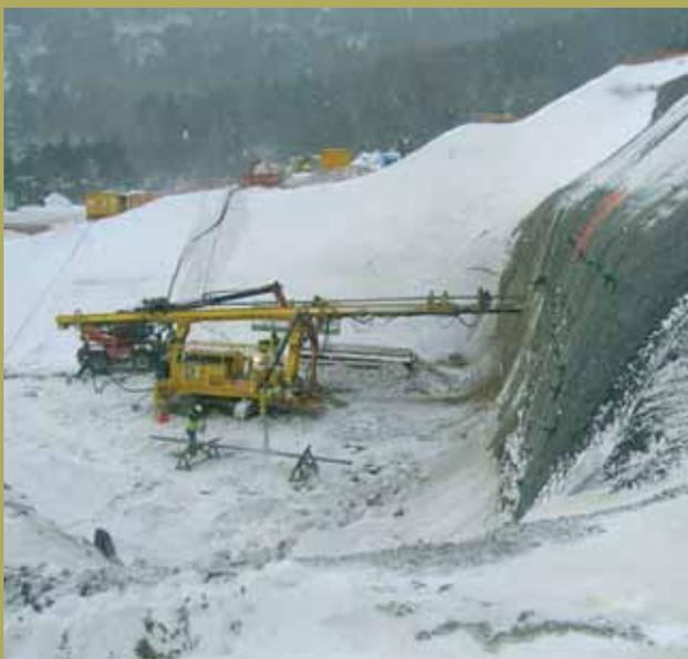
*Perforación de micropilotes. Boca Sur.*
