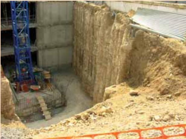
Figura 15. Pantalla sin viga de coronación.
