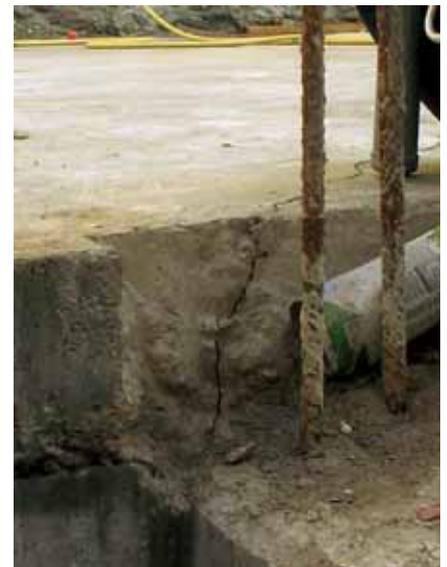
Figura 28. Losa fracturada.
