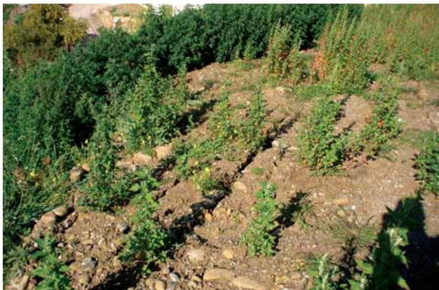
Figura 12. Marcas de deslizamiento en el trasdós de un muro de escollera.
