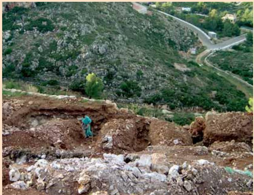
Figura 9. Cimentación escalonada en una ladera de fuerte pendiente.
