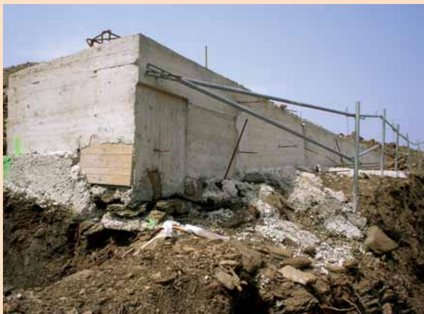
Figura 22. Apoyo deficiente de la zapata.
