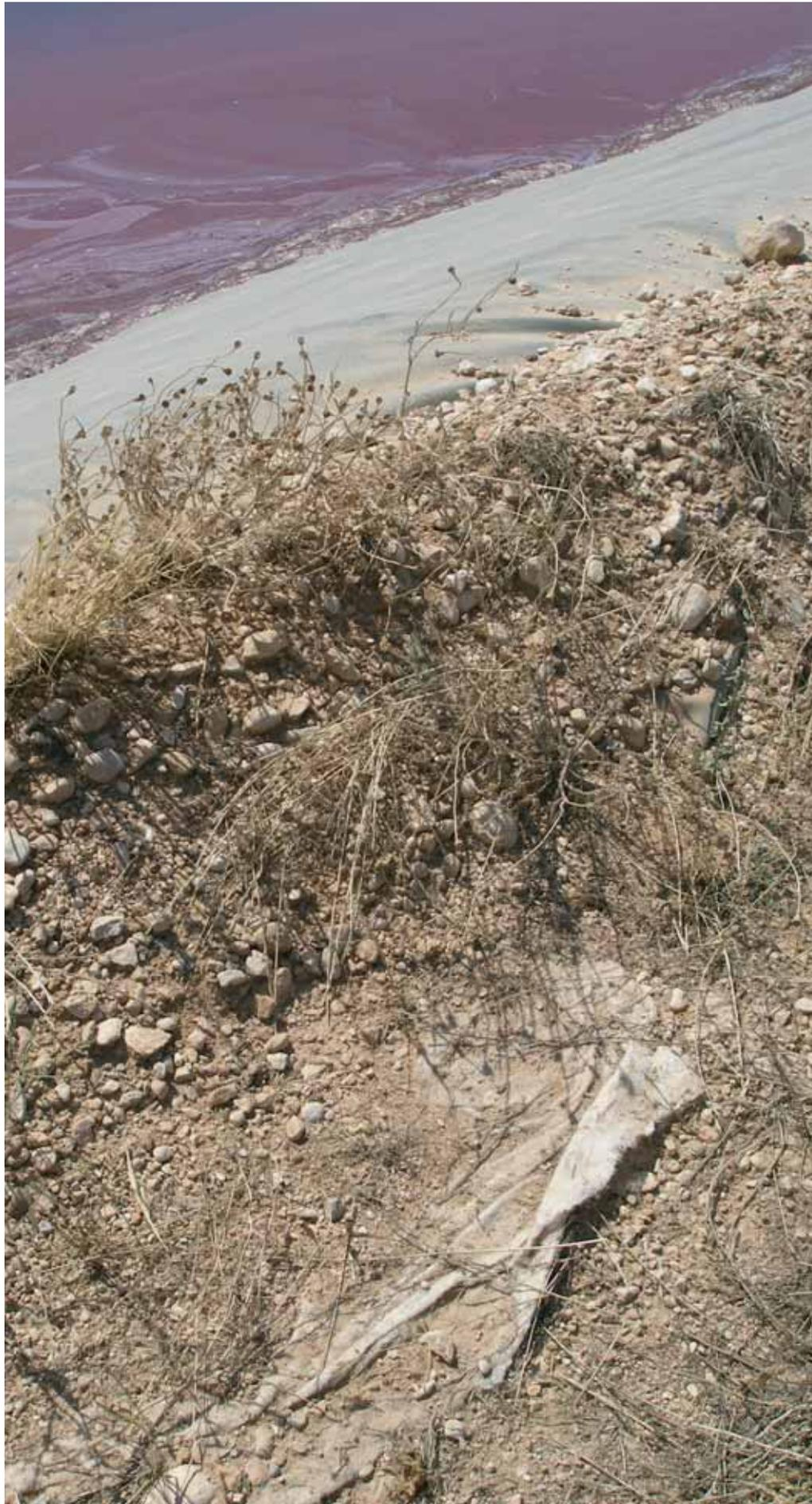
Figura 18. Balsa impermeabilizada para residuo de vinazas con geotextil.
