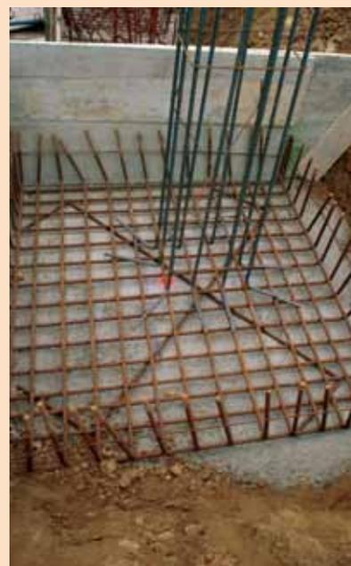
Figura 23. Pilar descentrado sobre zapata.
