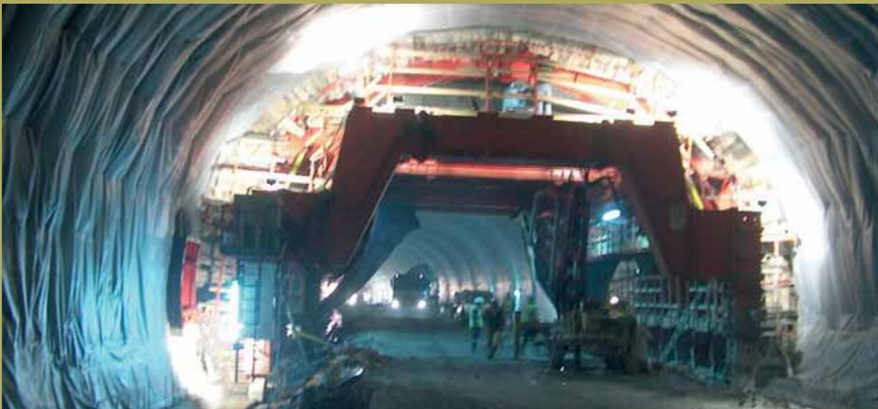
Carro de encofrado trabajando en zona impermeabilizada.
