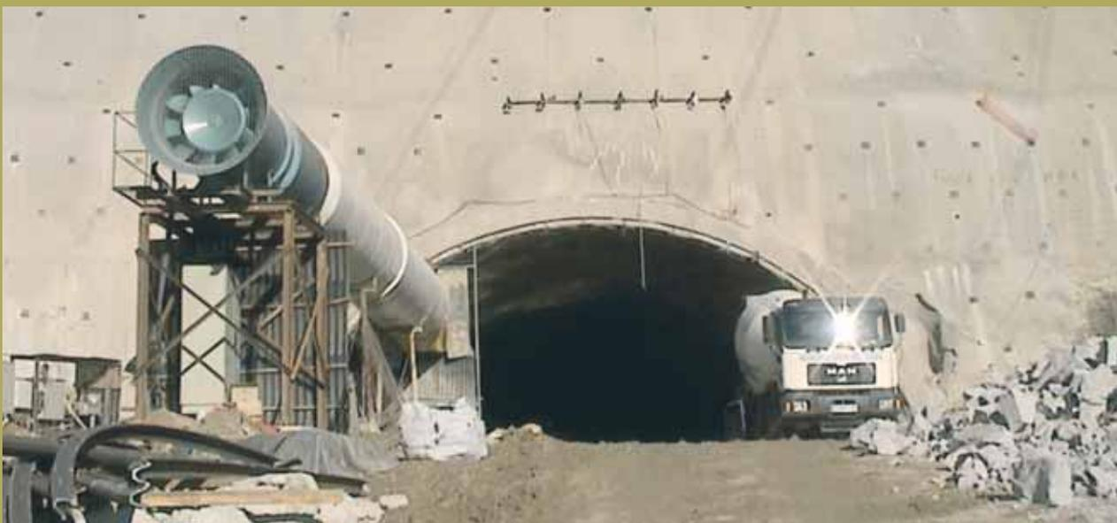
Vista de la boca Sur. Equipo de ventilación soplante.
