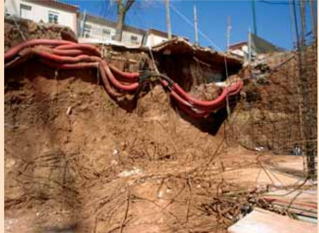
Figura 5. Batache que deja al descubierto una zapata del edificio colindante.
