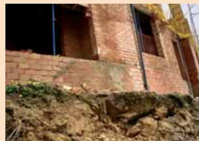
Figura 21. Deslizamiento que descalza la cimentación.
