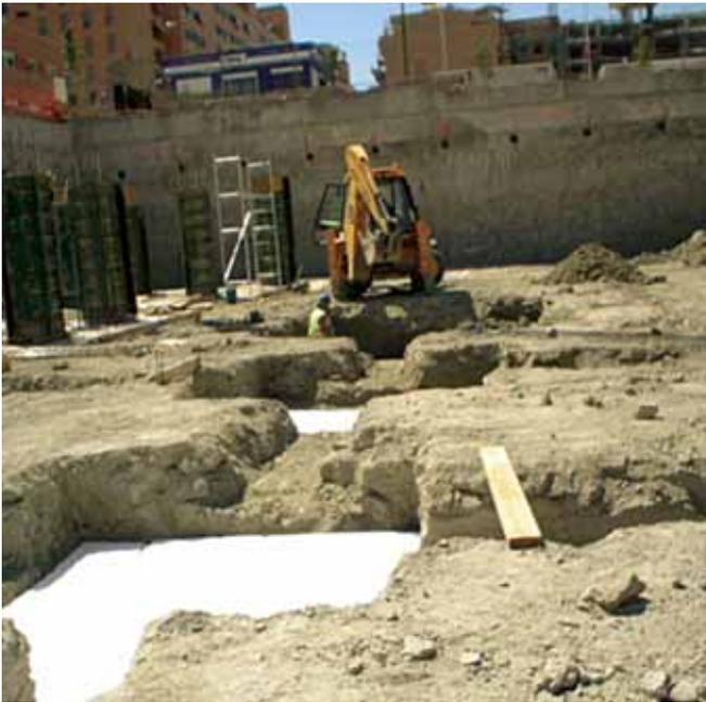
Figura 26. Introducción errónea de una lámina de porexpán para evitar la expansividad.
