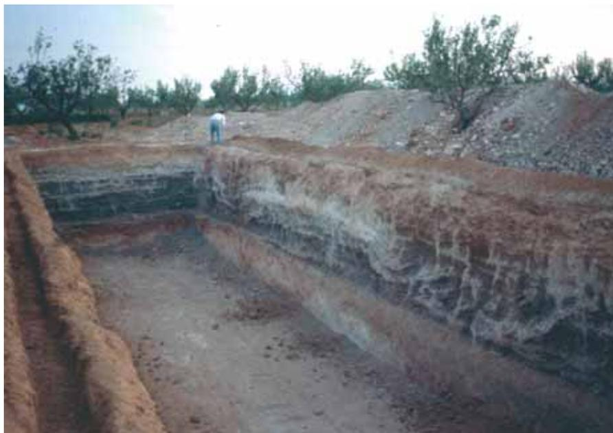
Figura 8. Excavación en materiales arcillosos cuaternarios bajo los que se encuentran formaciones de conglomerados y gravas con mayor permeabilidad.
