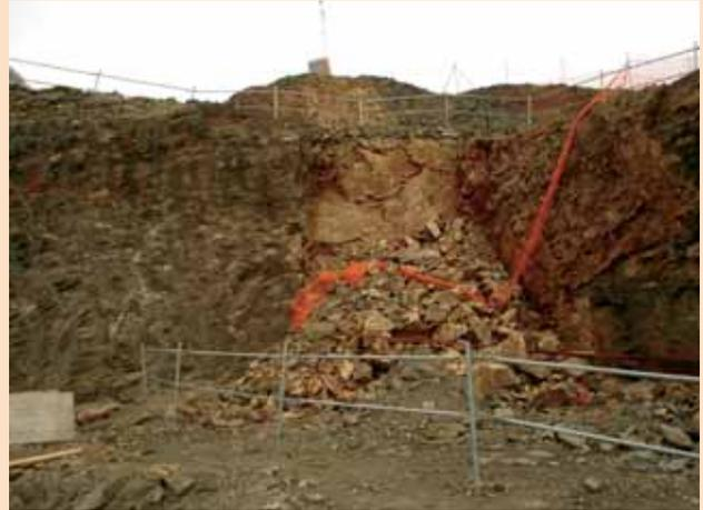
Figura 7. Deslizamiento de un talud en suelo.
