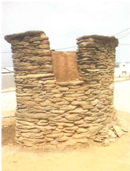
Vista lateral del horno en el que se observa la abertura or la que se introducción las piezas en la cámara superior para su cocción.
