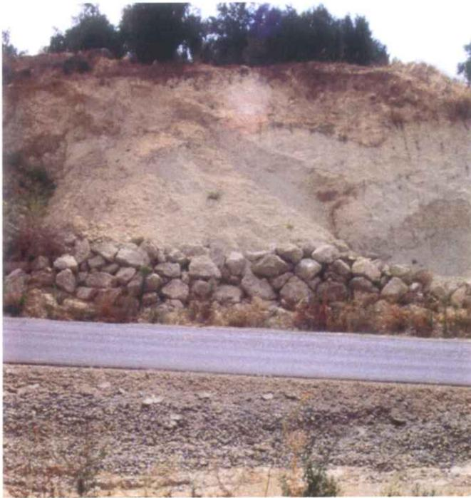
Figura 5a. Roturas de taludes en las AAG alteradas.
