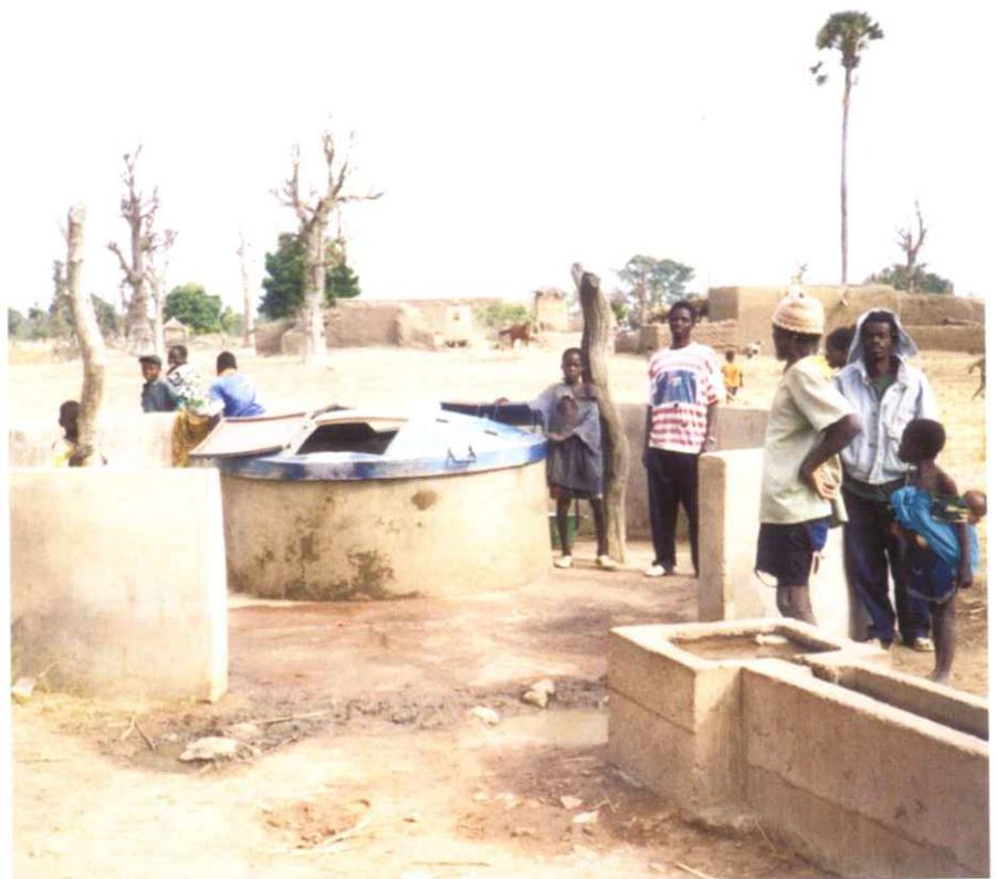
Figura 3. Pozo moderno con protección de su brocal.
