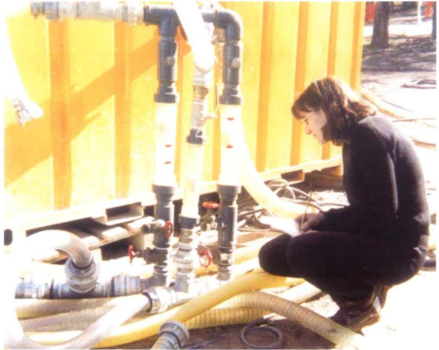
Figura 1. Trabajos de saneamiento de suelos aplicando sistema de extracción de vapores.
