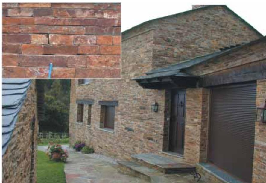
Figura 15. Casa recientemente construida con cuarcita de la Serie de los Cabos.
