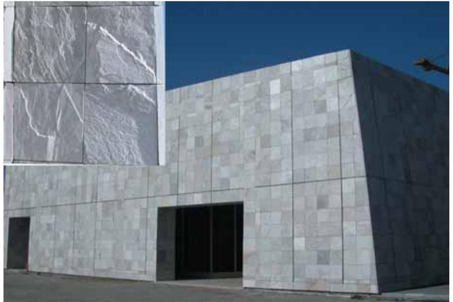
Figura 8. Uno de los edificios en construcción en la Ciudad de la Cultura de Santiago. Se emplea la cuarcita de Muras tanto en revestimientos exteriores como interiores, suelos y cubiertas.
