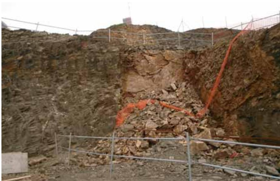
Figura 2. Excavación con derrumbe, en un talud rocoso.
