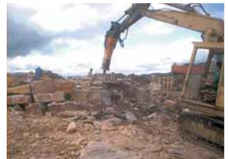
Figura 10. Cantera Lastraspareiras, arranque mediante retroexcavadora adaptada con un martillo.
