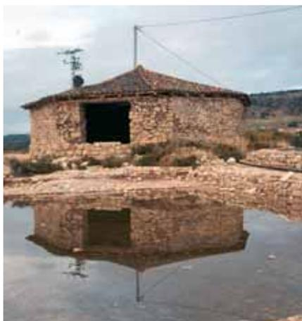
Figura 7. Este tipo de edificaciones albergaban las norias. El trabajo en las norias se realizaba durante todo el año, por lo que era necesario resguardarse de las inclemencias del tiempo. Los edificios eran, por lo general, de planta octogonal, para semejar una planta lo más circular posible y permitir así el trabajo de giro de la mula en torno a la noria.
