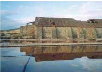
Figura 6. Vista actual del alfó de San Marcos, en La Olmeda, con evidente deterioro de su cubierta, debido a las inclemencias del tiempo y la falta de mantenimiento de los últimos años.
