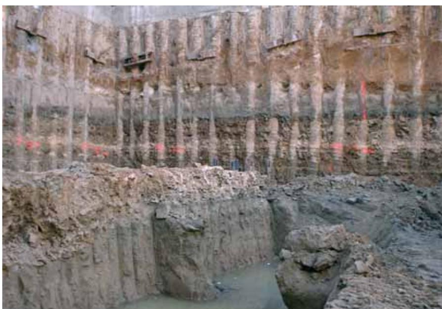
Figura 4. En primer término, presencia de agua en la excavación, y en segundo término, se observan unos pilotes formando una pantalla.
