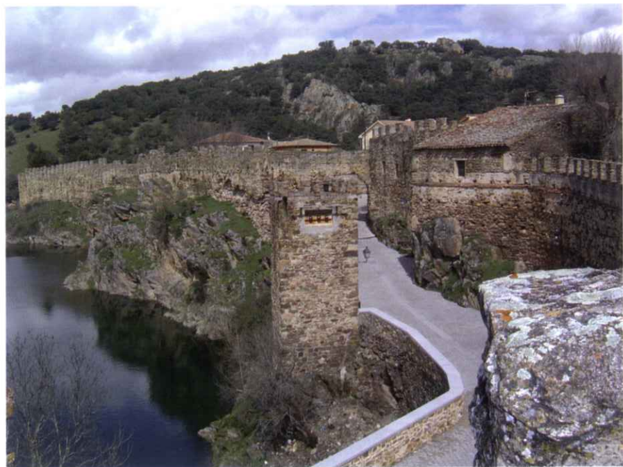
Figura 5. Buitrago, junto al río Lozoya. Arquitectura tradicional de mampostería con los gneises locales.
