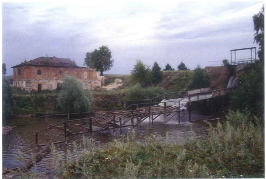
Figura 18. Ruinas de un lavadero de mineral y de edificios industriales en Voskresesnskoye (Bashkiria). El muro de la represa está construido con miles de toneladas de escorias de cobre.
