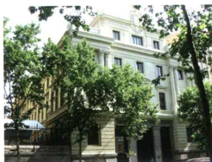
Figura 1. Sede Central del Instituto Geológico y Minero de España. Calle Ríos Rosas, 23. Madrid.
