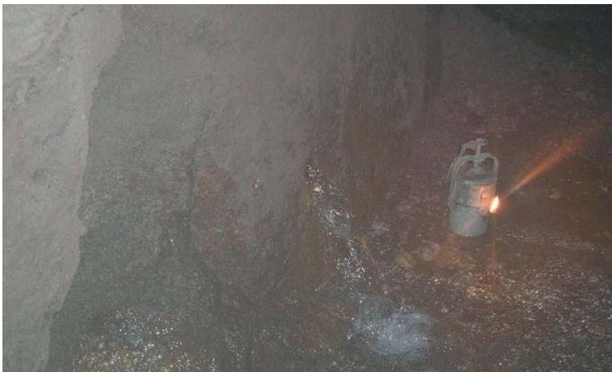
Figura 7. Alumbramiento en la parte inferior del hastial de una galería.
