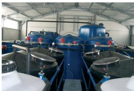
Figura 5. Vista de los filtros en el interior de la planta.
