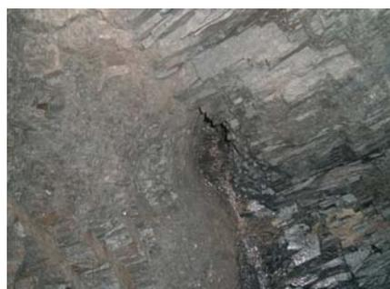
Figura 8. Alumbramiento de agua detrás de un dique.
