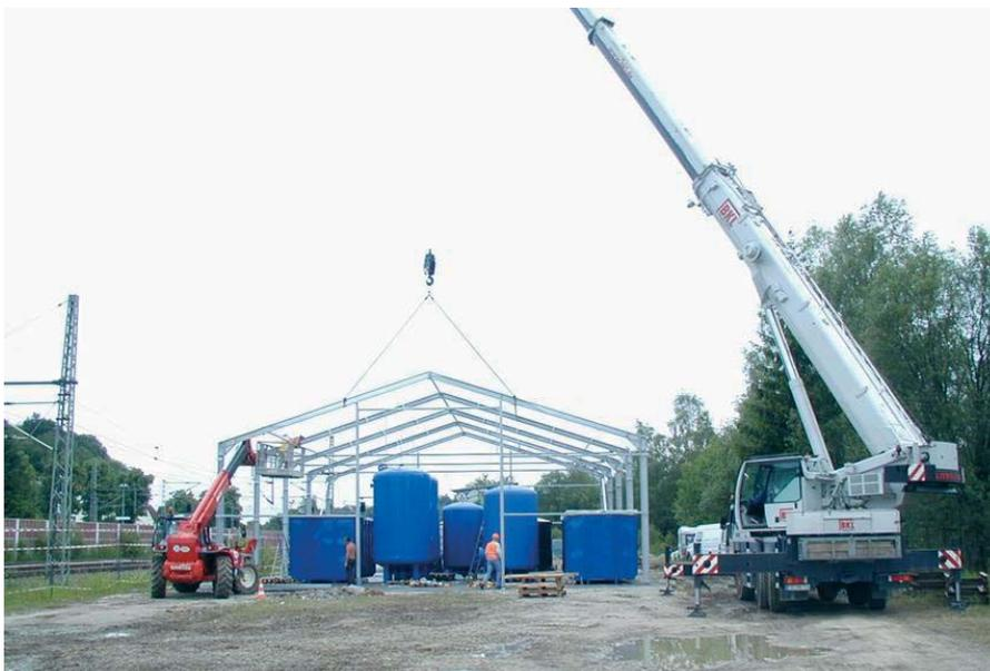
Figura 3. Labores de construcción de la nave donde se disponen los instrumentos de remediación.
