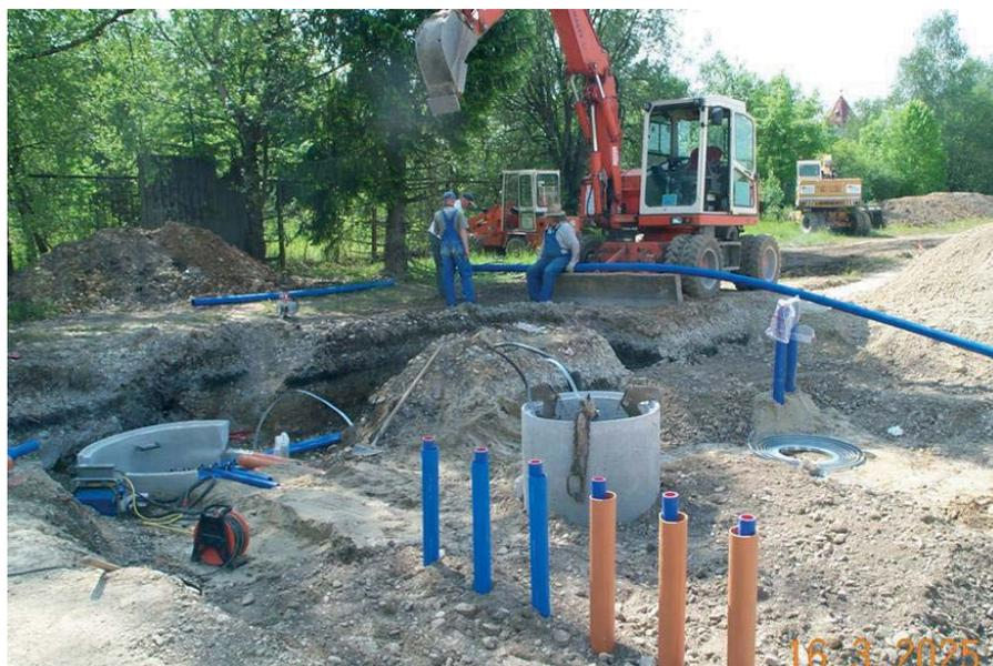
Figura 2b. Desarrollo de las labores de construcción de las zanjas.
