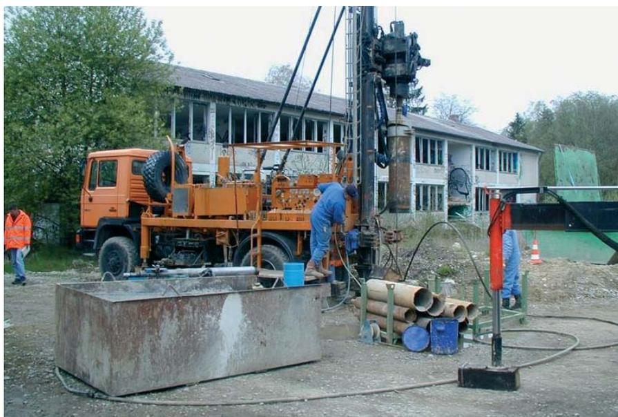
Figura 2a. Desarrollo de las labores de construcción de los pozos de extracción.
