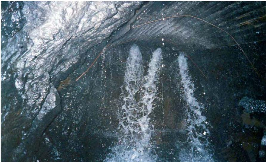
Figura 6. Alumbramiento de agua en el frente de una galería.
