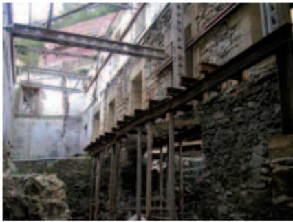
Figura 19. Recalce de una iglesia con micropilotes.
